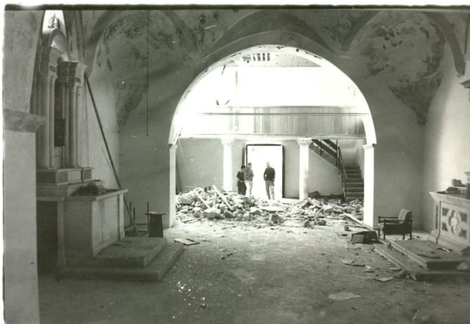
Slika 49. Unutrašnjost crkve nakon vojno oslobodilačke akcije Oluja (u donjem dijelu crkve vidi se urušena podna građa i stepenište koje je najvjerojatnije izrađeno tijekom posljednje prijeratne obnove)
