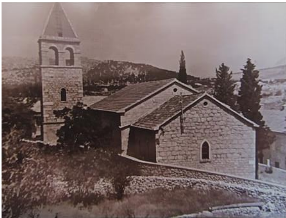
Slika 35. Crkva sv. Ante poslije urušavanja kupole sa dvostrešnim krovom
