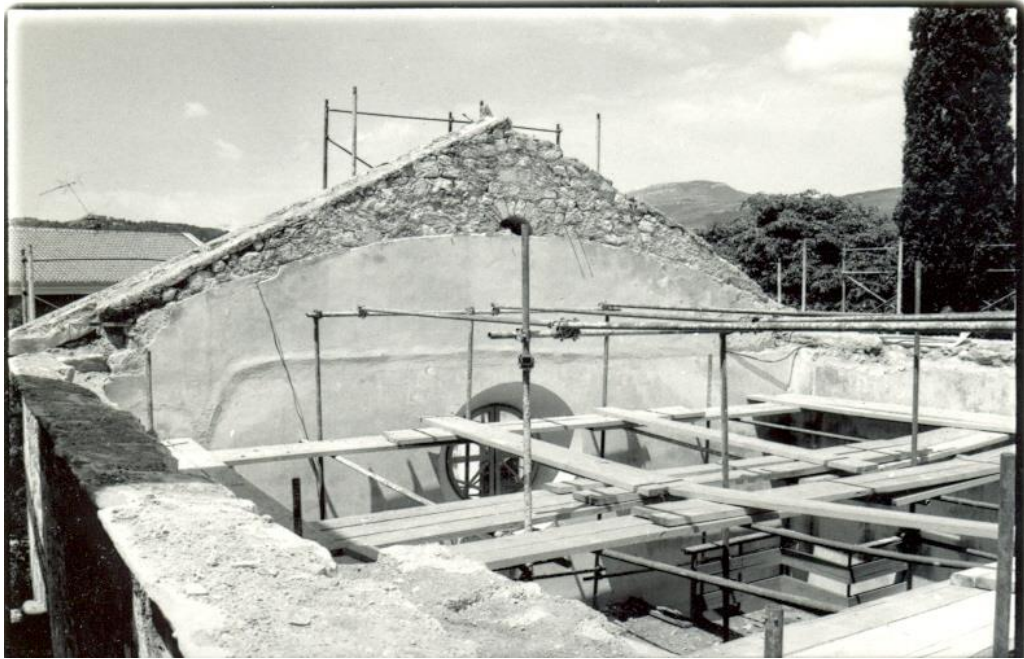
Slika 46. Radovi na krovu iznad zapadnog produžetka crkve sv. Ante
