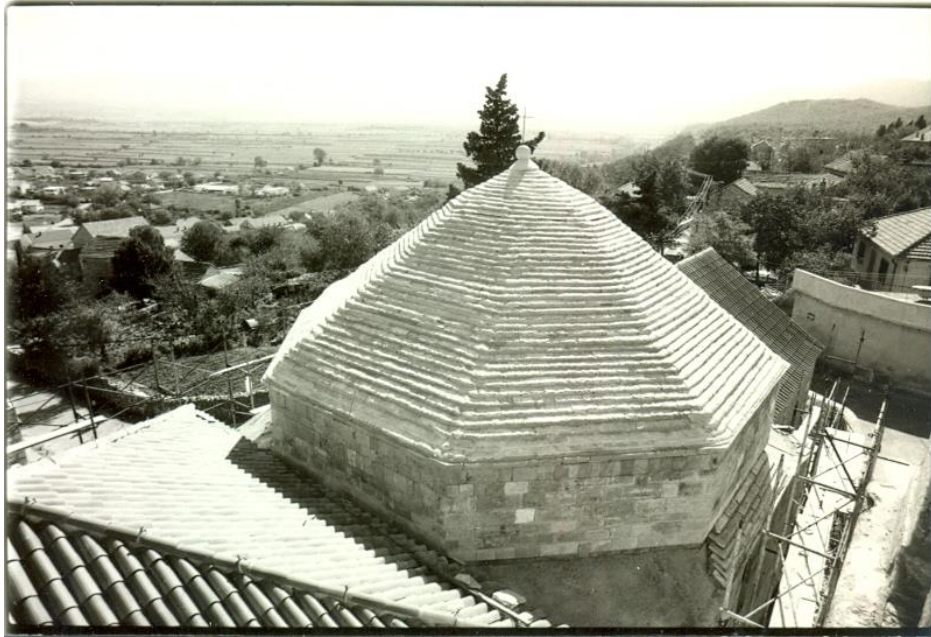
Slika 44. Kupola pokrivena kamenim pločama
