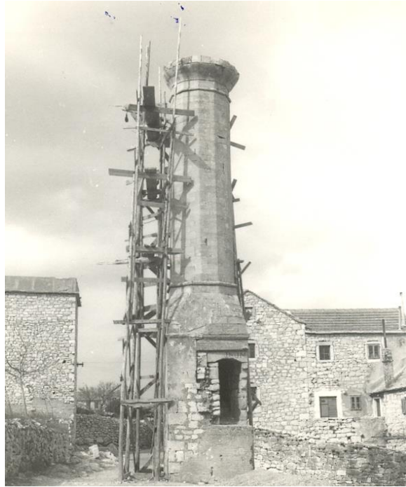
Slika 9. Završetak radova na minaretu 1968. godine
