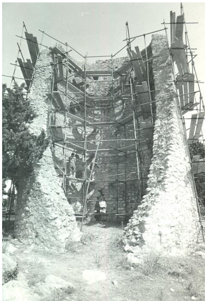
Slika 28. Inektiranje zidova kružne kule
