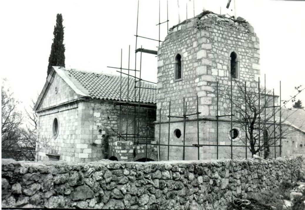
Slika 50. Saniranje ratnih oštećenja na crkvi sv. Ante u Drnišu
