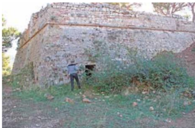
Slika 15. Pomoćni ulaz na unutarnjem hornwerku tvrđave sv. Ivana (preuzeto iz: I. Glavaš i J. Pavić, 2016., str. 95., snimio: J. Pavić)
