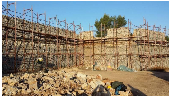
Slika 38. Radovi na obnovi tvrđave Barone (2015.) (preuzeto s: https://www.sibenik.in/?novosti=sibenik&title=foto-skele-na-sibenskoj-tvrđavi-barone&id=33970&fb_comment_id=627321277390576_627395894049781 , pristup 12.9.2020.)
