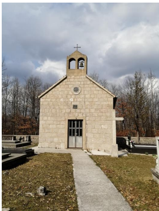
Slika 25. Glavno pročelje (Foto: Marko Kojundžić)
