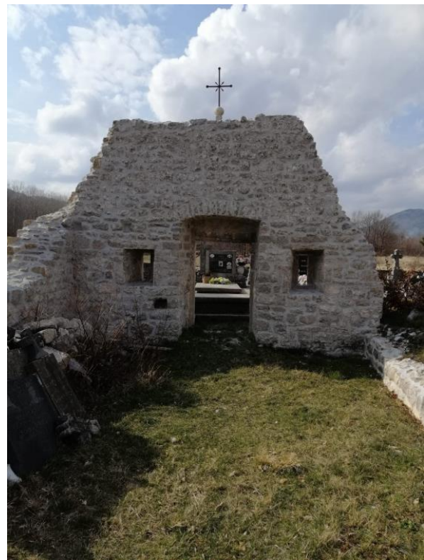
Slika 24. Unutarnje lice zapadnog pročelja – pogled prema zapadu (Foto: Marko Kojundžić)
