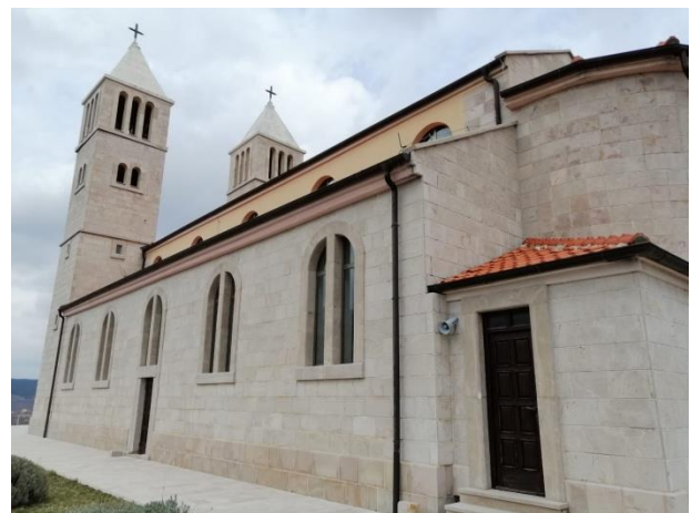
Slika 74. Vanjski izgled južnog pročelja (Foto: Marko Kojundžić)
