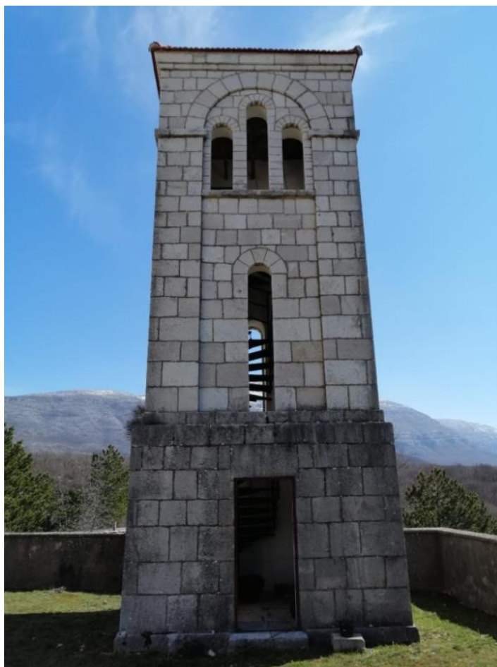
Slika 68. Vanjski izgled zvonika (Foto: Marko Kojundžić)
