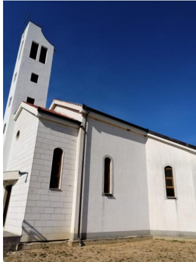
Slika 51. Sjeverno pročelje (Foto: Marko Kojundžić)
