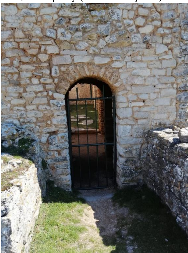
Slika 63. Ulaz na zapadnom pročelju (Foto: Marko Kojundžić)
