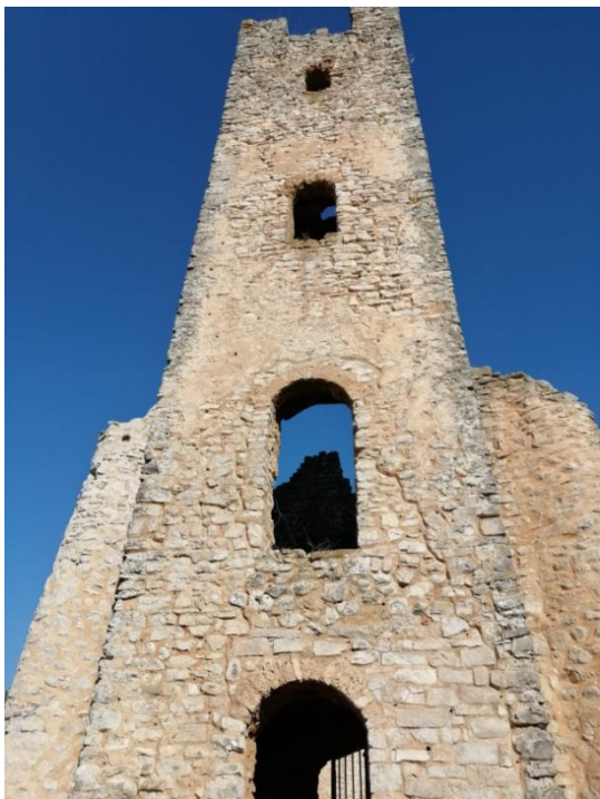
Slika 57. Vanjski izgled zvonika (Foto: Marko Kojundžić)
