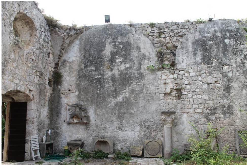
Slika 8. Južni bočni zid s vidljivim otiscima položaja nekadašnjih traveja.
