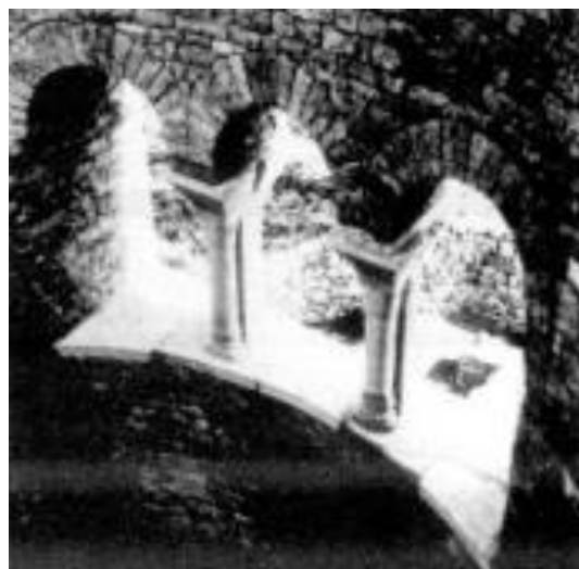
Slika 63. Trodijelni prozor s izvornim stupićima i kapitelima s impostima nakon odzidavanja (Izvor: D. Domančić, 1994.)
