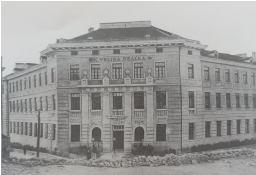
Slika 51. Zgrada Velike realke u Splitu u vrijeme Kamila Tončića (preuzeto: Piplović S., Kamilo Tončić , Split, 1991., 74.)
