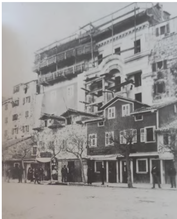
Slika 47. Kuća I. Save, tijekom nadogradnje sa skelom na mansardi (preuzeto: Piplović S., Kamilo Tončić, Split, 1991., 61.)
