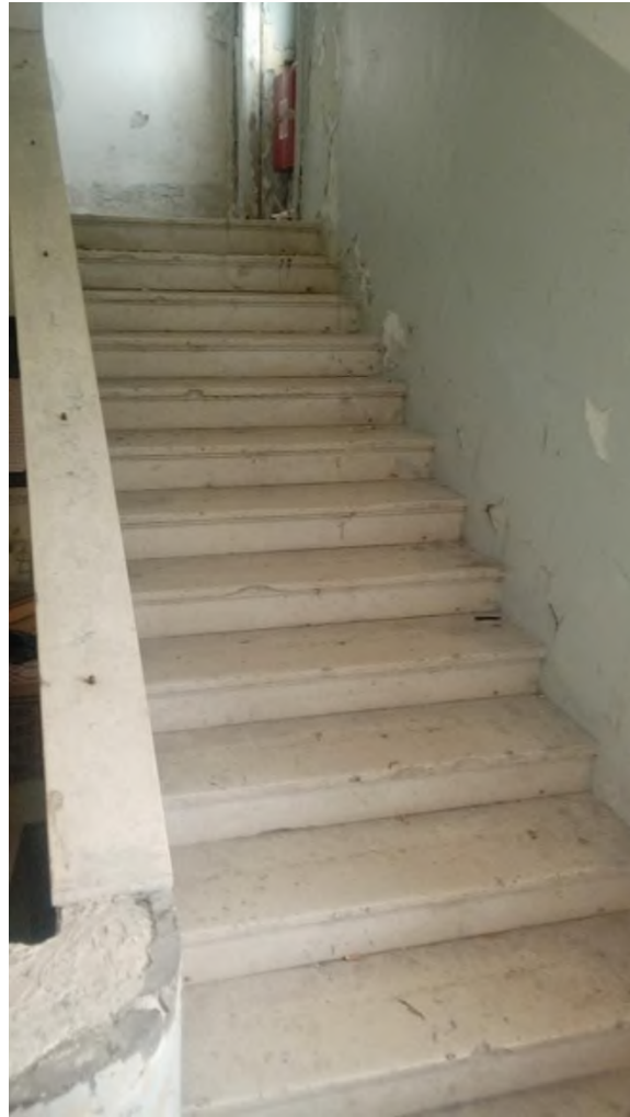
slika 29. Zatečeno stanje stubišta Hrvatskog doma prije restauracije, 2017. (privatno vlasništvo)
