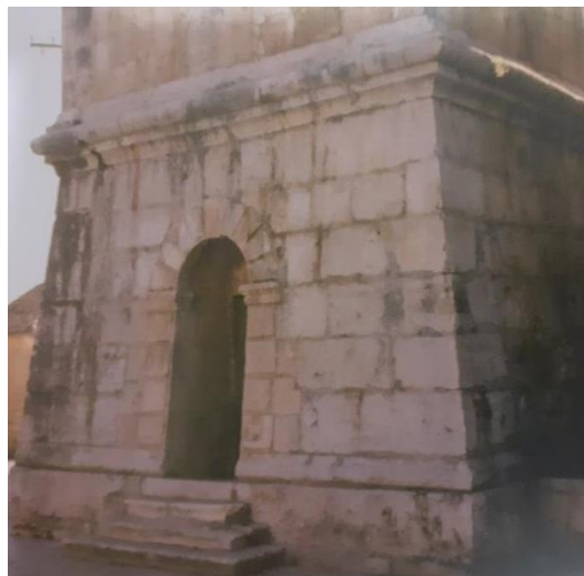
Slika 10. Megalitski blokovi ugrađeni u zvoniku (Jeličić Radonić, J. 1995. Str. 27)
