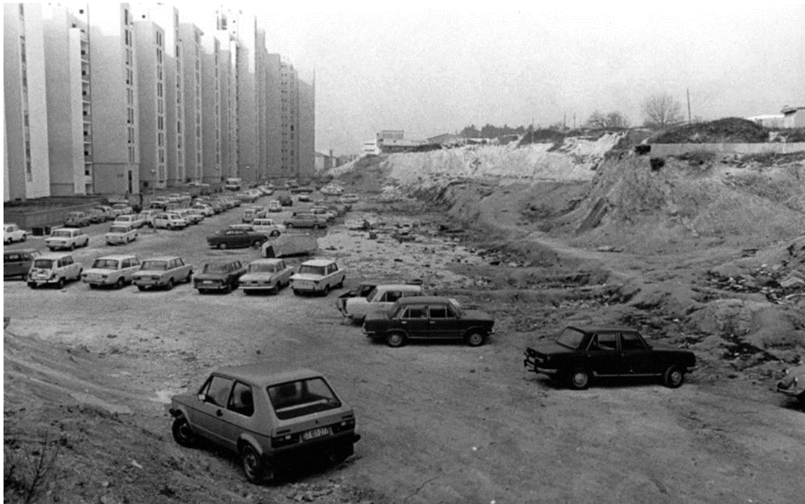
Slika 21. Parking na Sućidru, 1983.
