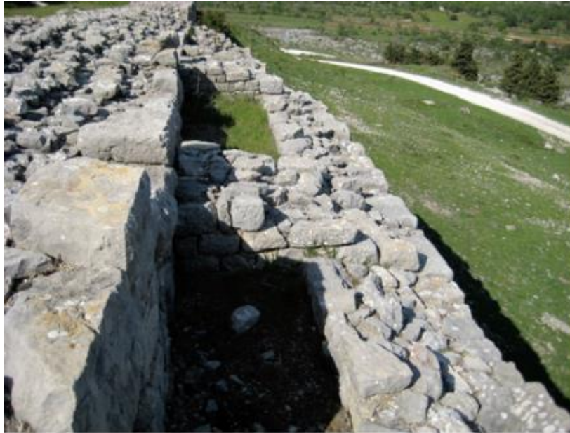
Slika 19. Fotografija potpornjaka povezanih zidom
