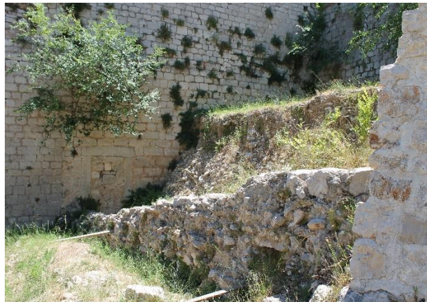
Slika 30. Pogled na zid sjevernog podzida sa sjevera
