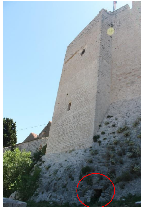
Slika 32. Otvor na sjeveroistočnom bedemu kaštela
