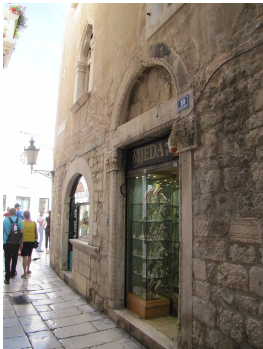
Slika 49 Ulazni portal sjevernoga pročelja palače Grisogono
