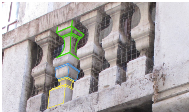
Slika 23 Balustrada serliani palače Cindro
