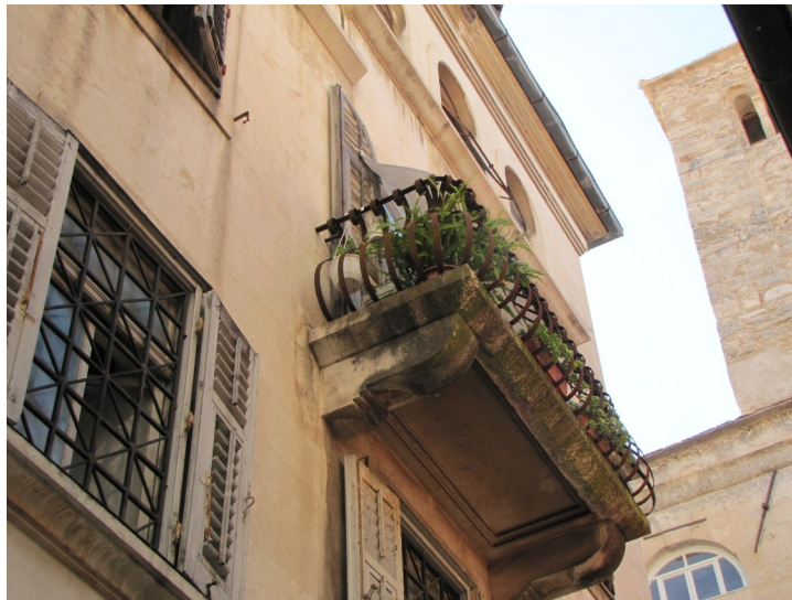
Slika 25 Balkon sjevernoga pročelja zgrade na adresi Krešimirova ulica 2
