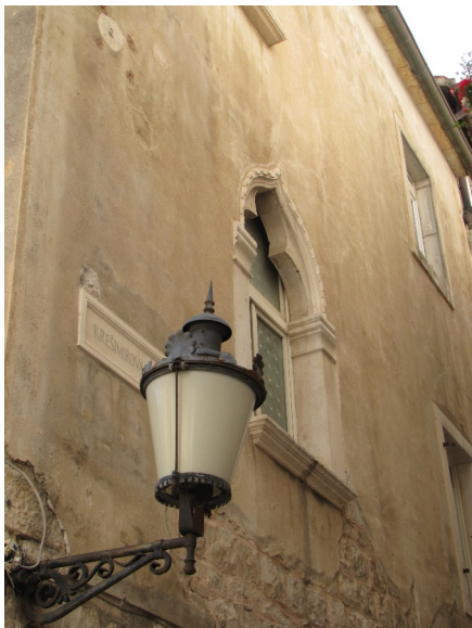
Slika 45 Prozor sjevernoga pročelja palače Grisogono
