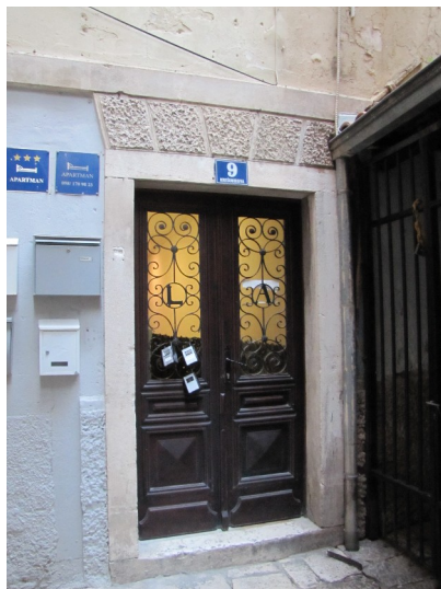
Slika 52 Ulazni portal na adresi Krešimirova ulica 9
