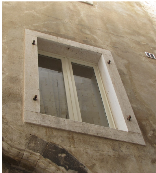
Slika 46 Prozor sjevernoga pročelja palače Grisogono
