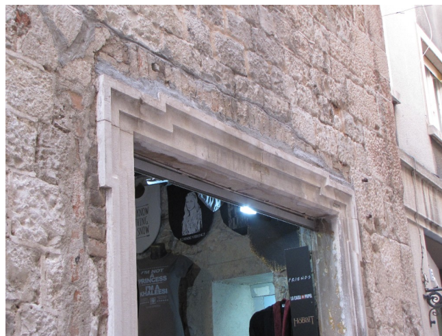
Slika 56 Ulazni portal na adresi Krešimirova ulica 8
