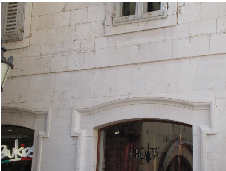
Slika 51 Ulazni portal i prozori na adresi Krešimirova ulica 11
