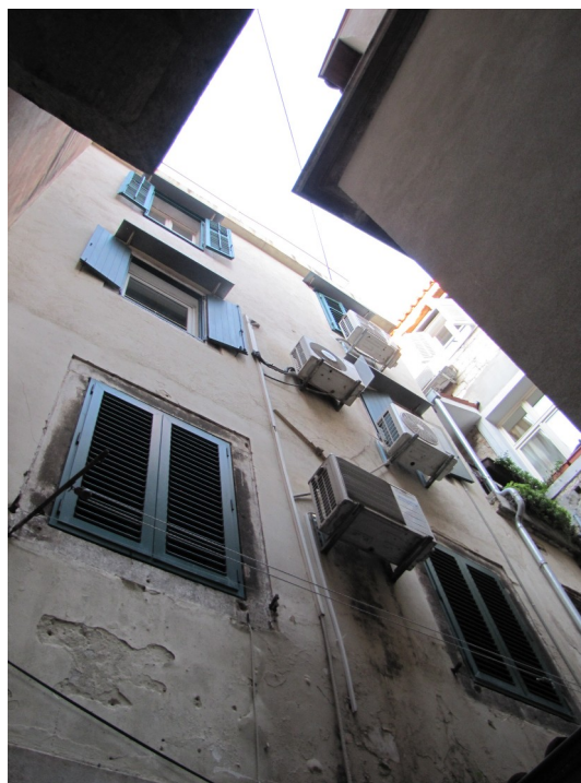
Slika 6 Katovi južnog pročelja zgrade na adresi Krešimirova ulica 9
