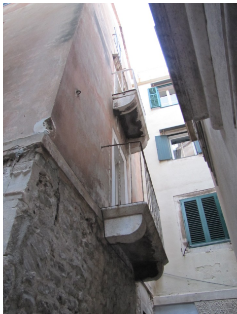
Slika 7 Istočni zid zgrade na adresi Krešimirova ulica 7
