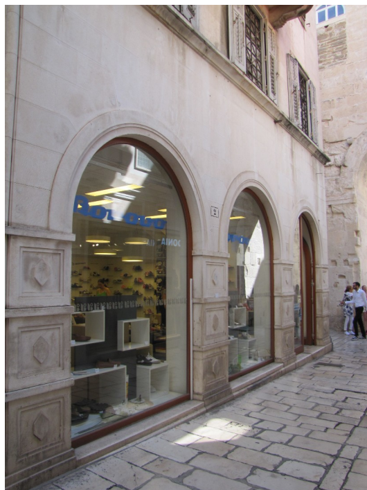
Slika 13 Prizemlje sjevernog pročelja zgrade na adresi Krešimirova ulica 2
