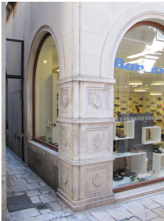
Slika 44 Stub sjevernog pročelja zgrade na adresi Krešimirova ulica 2
