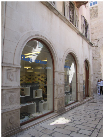
Slika 38 Lukovi u prizemlju na adresi Krešimirova ulica 2
