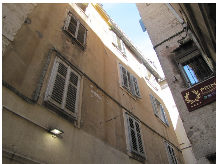
Slika 9 Katovi južnog pročelja zgrade na adresi Krešimirova ulica 5
