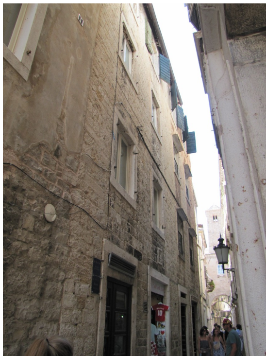
Slika 17 Sjeverno pročelje zgrade na adresi Krešimirova ulica 8
