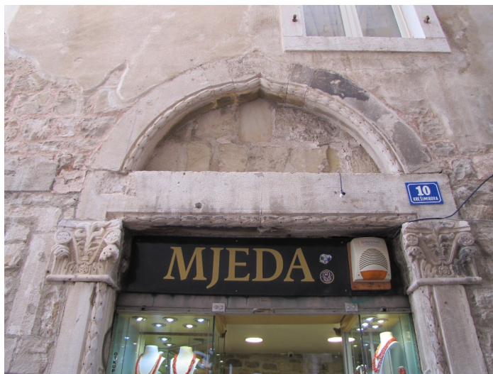
Slika 36 Luk zapadnih ulaznih vrata sjevernoga pročelja palače Grisogono
