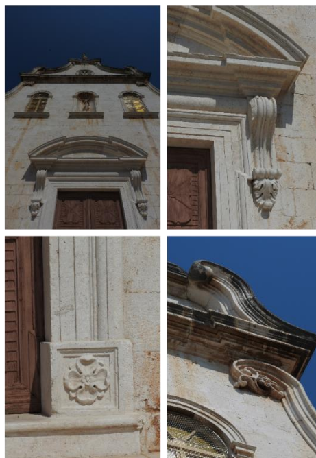
Slika 17. Detalji pročelja župne crkve u Milni
