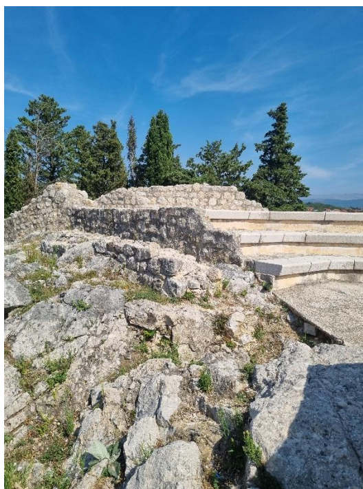
Slika 5. Vidljivi ostaci novijeg i ranijeg vremena gradnje i obnove utvrde Kamičak
