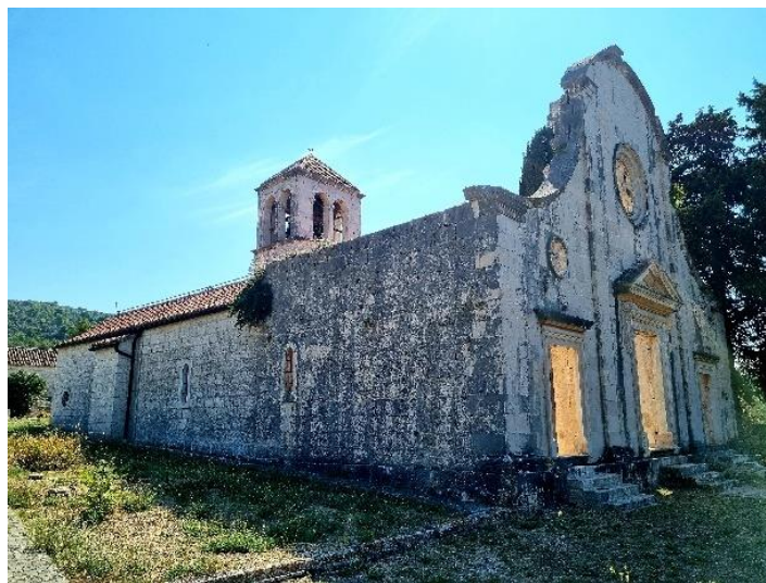
Slika 44. Pogled na bočne zidove
