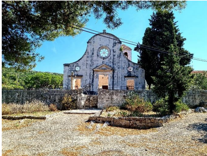
Slika 41. Nedovršeno pročelje novijeg dijela crkve sv. Jurja na Velom Drveniku
