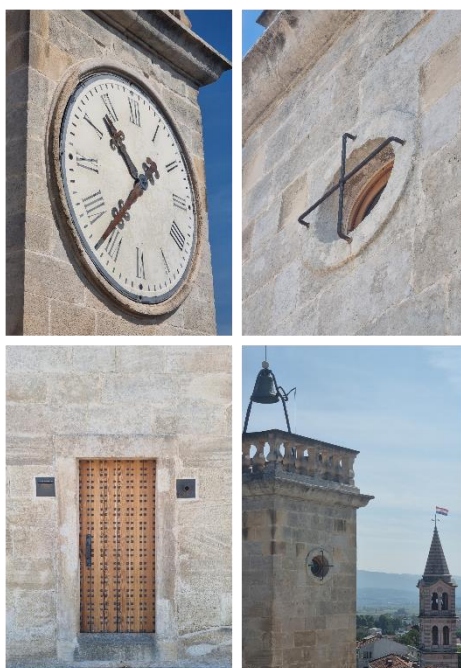
Slika 4. Detalji utvrde Kamičak
