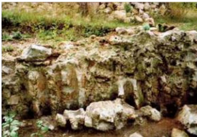
Slika 43. Temelji palisada otkopani 1999. godine
