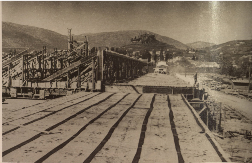
Krov tvorničke zgrade
