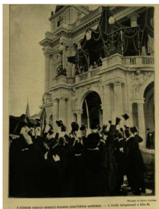
Slika 13. Franjo Josip I. označava kraj radova na zgradi HNK u Zagrebu 184
