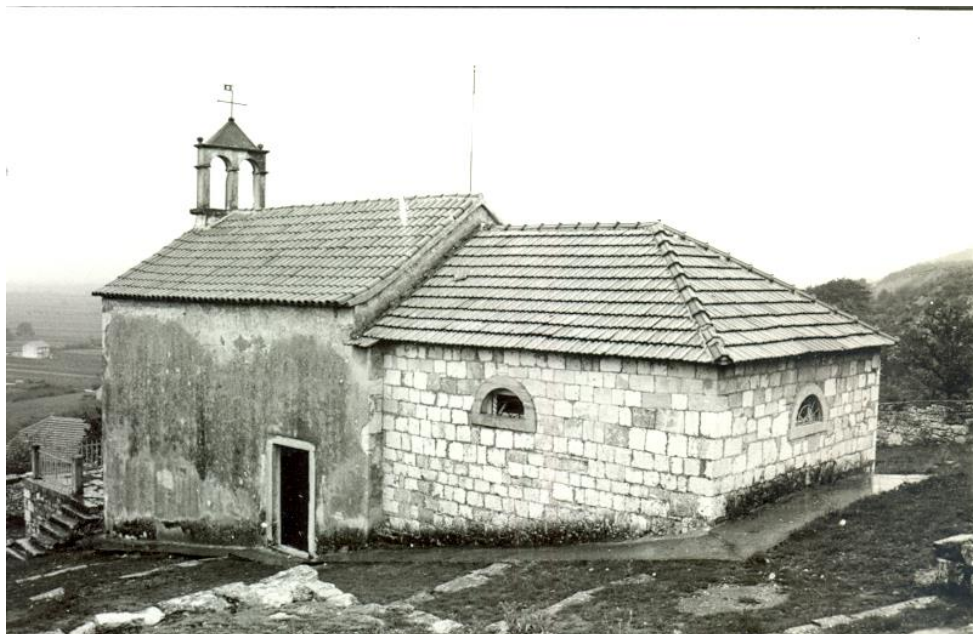
Slika 56. Sjeverno pročelje crkve sv. Roka
