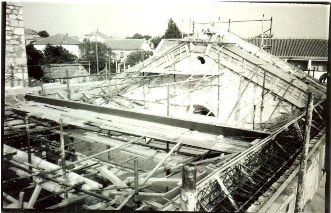
Slika 47. Radovi na krovu iznad prezbiterija
