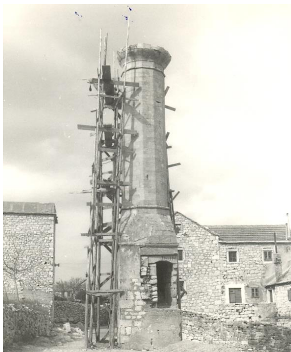
Slika 9. Završetak radova na minaretu 1968. godine
