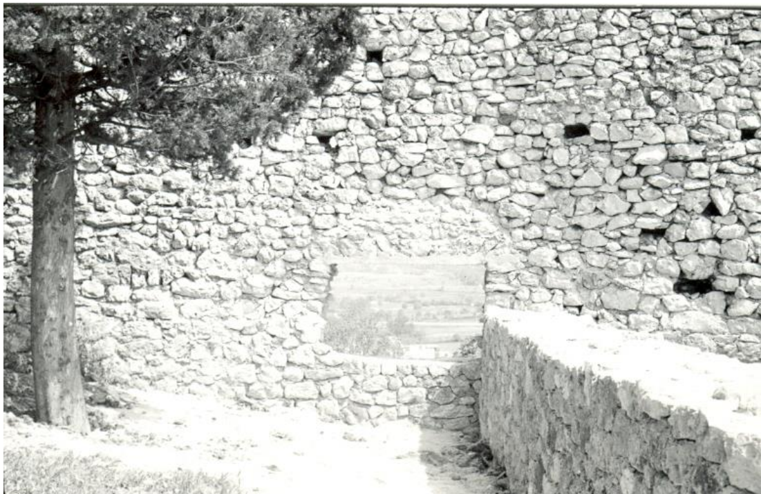
Slika 27. Obodni zid i spojni zid poslije rekonstrukcije 1988. godine
