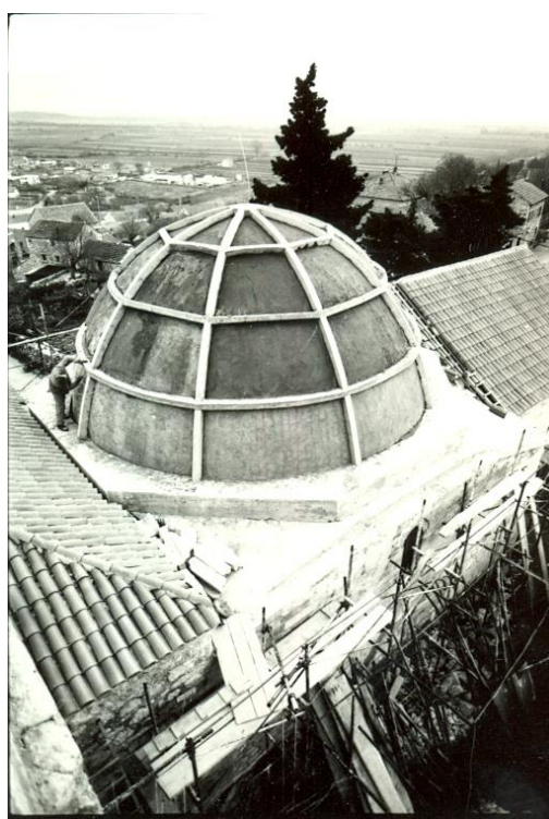
Slika 43. Ferrocementna kupola
