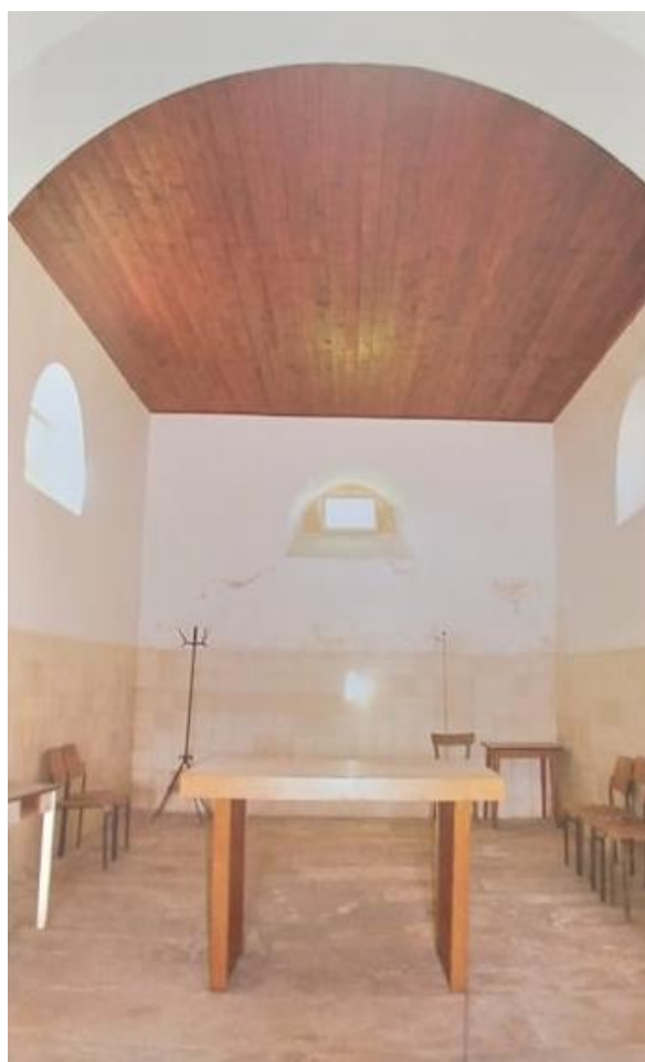
Slika 58. Svetište crkve sv. Roka prije obnove
