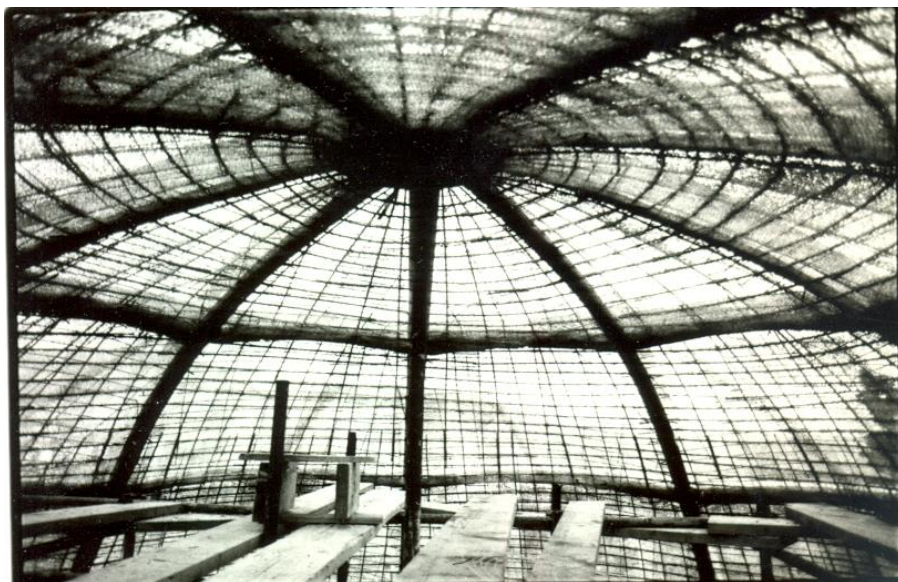
Slika 41. Armatura ferocementene kupole
