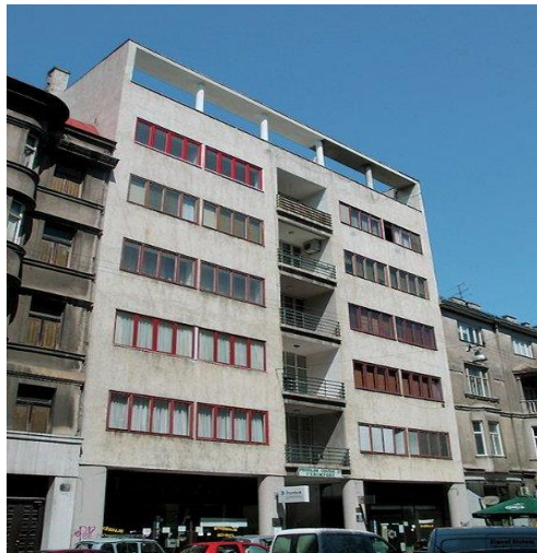
Slika 1. Drago Ibler, kuća Wellisch u Vlačkoj ulici, 1930.
