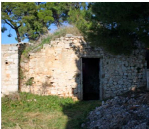
Slika 18. Pogled na glavno pročelje barutane na tvrđavi sv. Ivana (preuzeto iz: I. Glavaš, 2017., str. 222., snimio: I. Glavaš)
