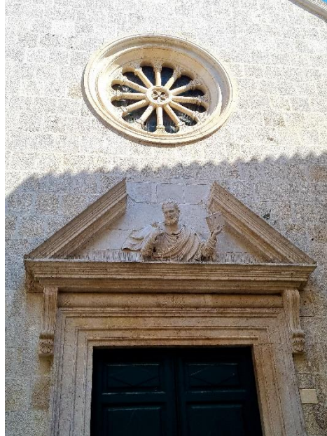
Slika 8. Detalj pročelja crkve sv. Petra u Trogiru
