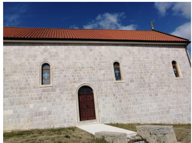
Slika 15. Južno pročelje (Foto: Marko Kojundžić)
