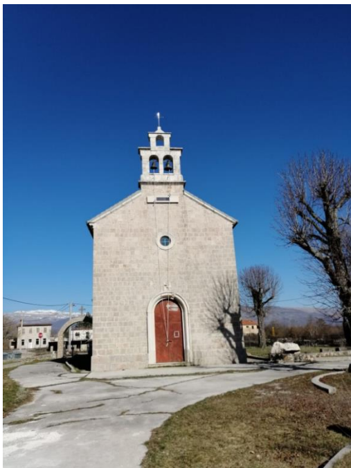
Slika 32. Ulazno pročelje (Foto: Marko Kojundžić)
