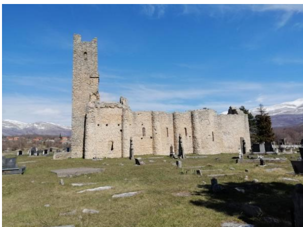
Slika 61. Južno pročelje (Foto: Marko Kojundžić)
