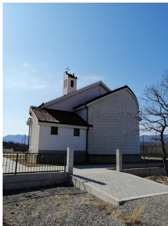
Slika 48. Crkveno začelje orijentirano prema zapadu (Foto: Marko Kojundžić)
