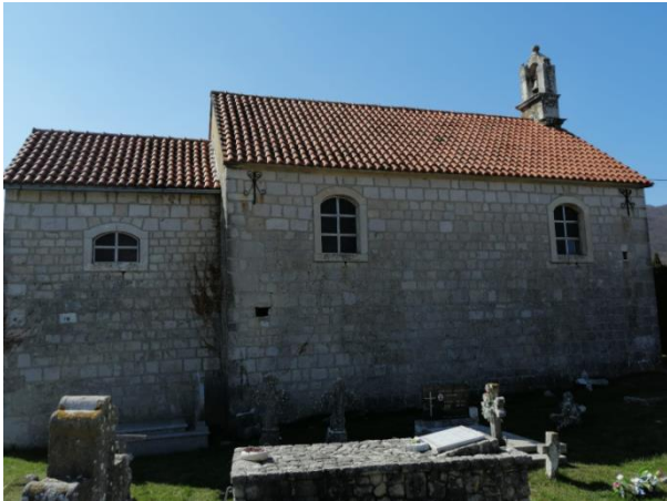
Slika 10. Istočno pročelje (Foto: Marko Kojundžić)
