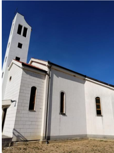
Slika 51. Sjeverno pročelje (Foto: Marko Kojundžić)
