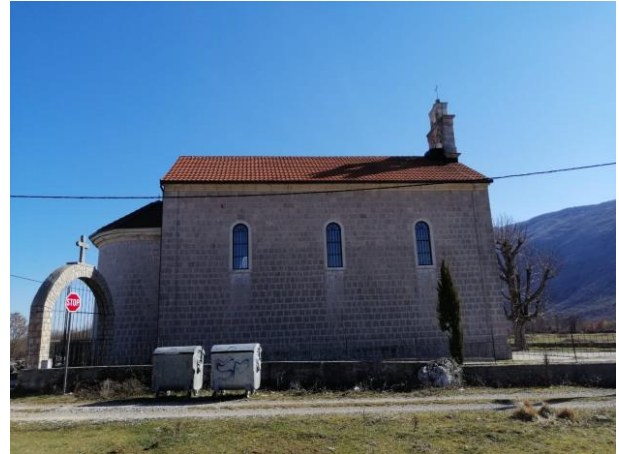
Slika 35. Sjeverozapadno pročelje (Foto: Marko Kojundžić)
