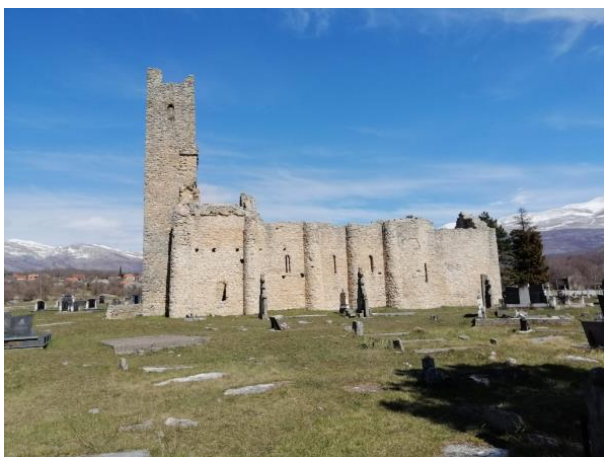
Slika 61. Južno pročelje (Foto: Marko Kojundžić)
