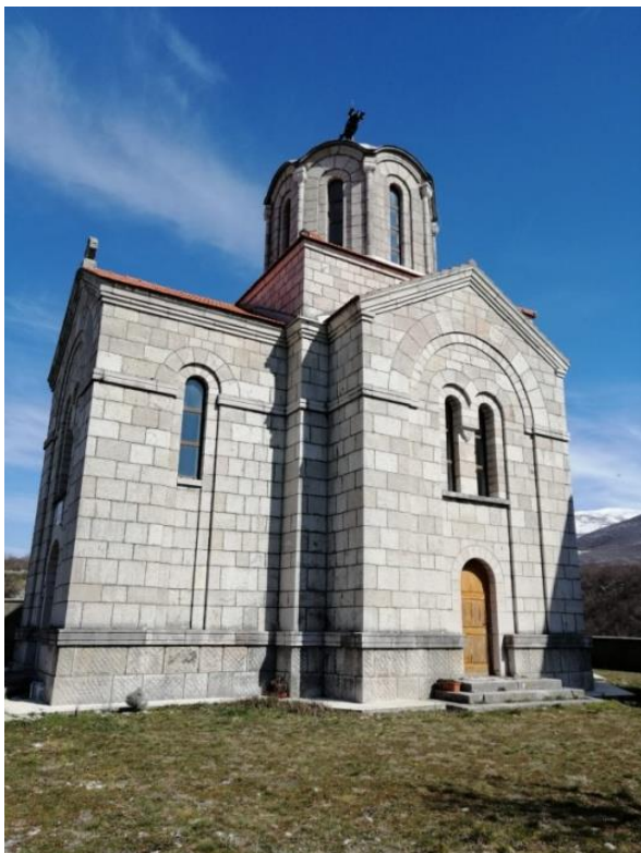
Slika 67. Južno pročelje (Foto: Marko Kojundžić)
