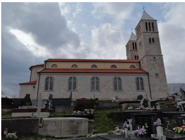
Slika 73. Vanjski izgled sjevernog pročelja (Foto: Marko Kojundžić)
