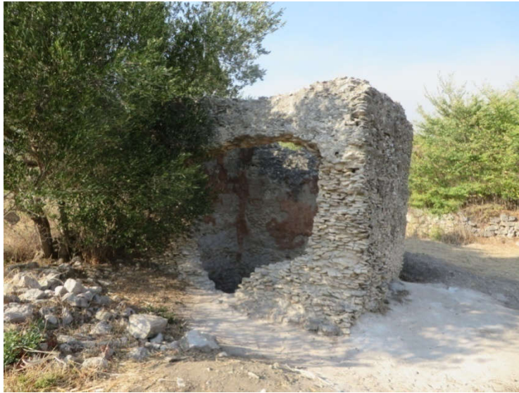
Slika 25. Opus caementicium -Cisterna na Murteru (Colentum)
