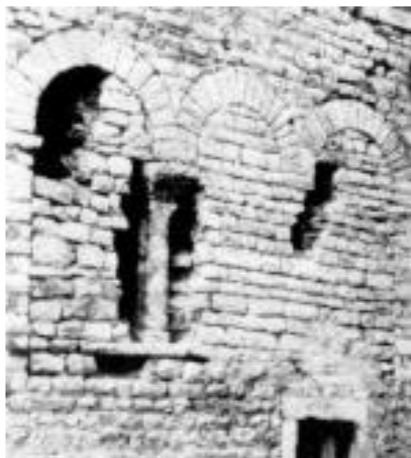
Slika 62. Otvaranje zazidanog trodijelnog prozora (Izvor: D. Domančić, 1994.)
