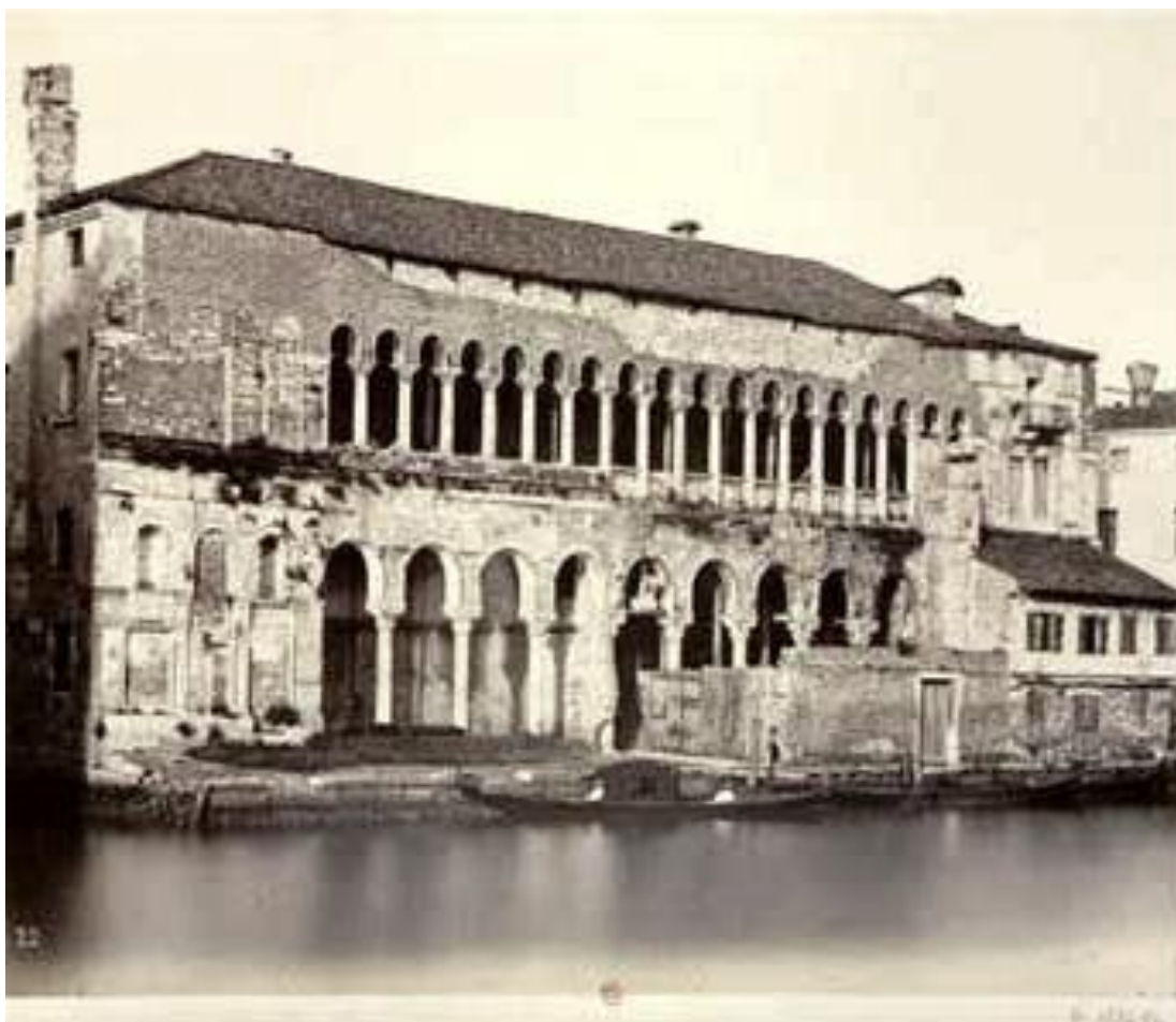
Slika 31: Fondaco dei Turchi 1853-1858, malo prije restauracije. Fotografija: Carlo Naya
