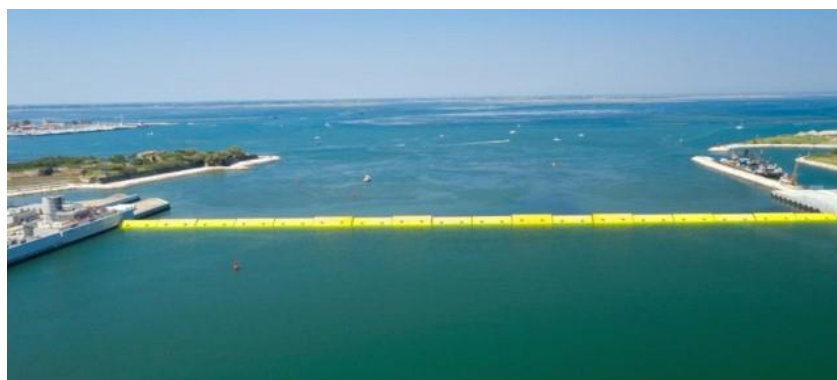
Slika 48: Mobilne barijere sustava MOSE
