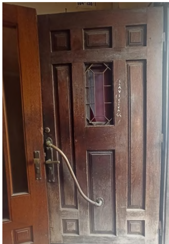
Slika 41. Vrata zapadnog ulaza u kuću (L. Vojnović, fotografirano: 18. 5. 2022., Split)
