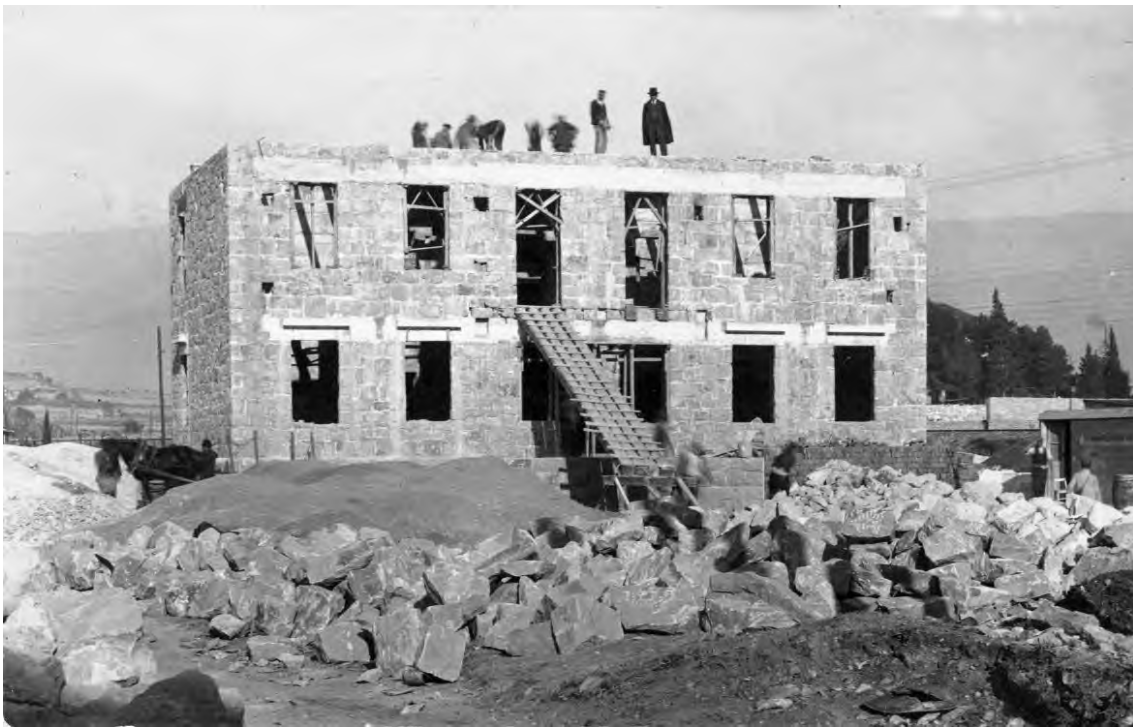
Slika 35. Kuća u izgradnji (privatno vlasništvo)
