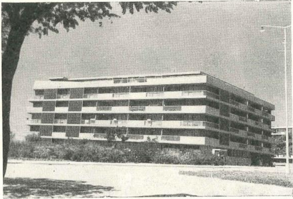
Slike 8. Stambeni blok na Bačvicama, Stanko Fabris
