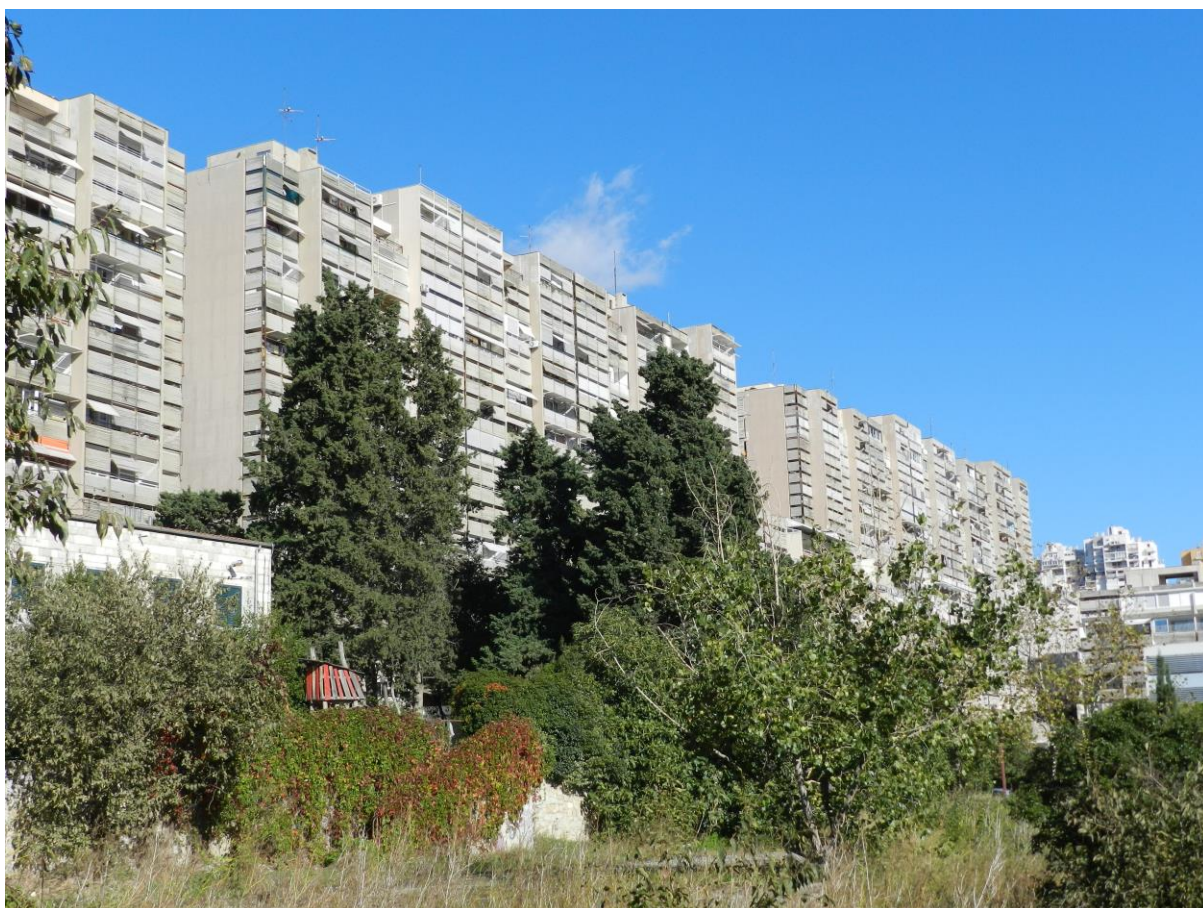
Slika 16. Pogled na zgrade u Papandopulovoj ulici
