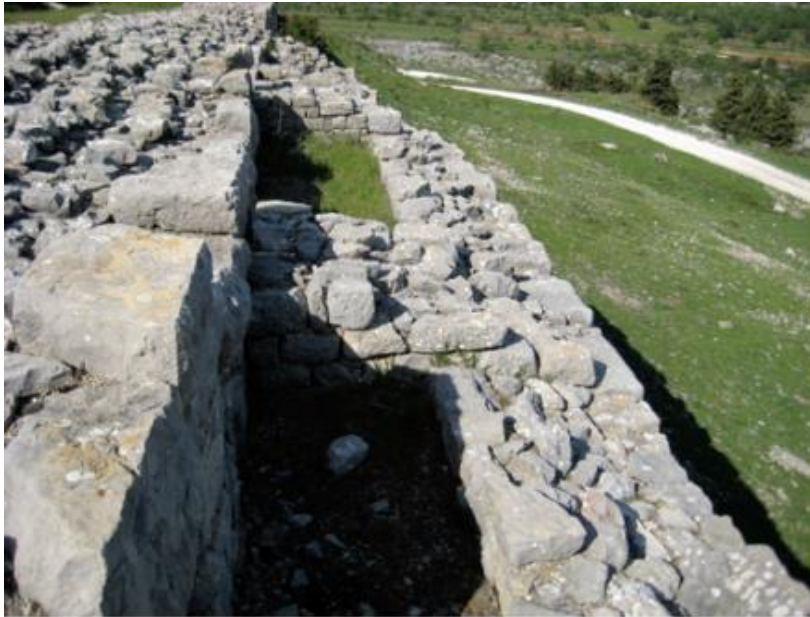
Slika 19. Fotografija potpornjaka povezanih zidom
