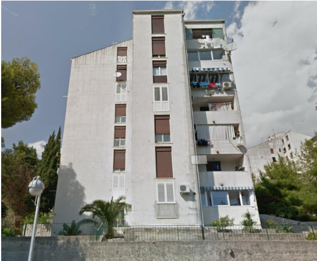
Slika 70. Pogled na južno pročelje zgrade 1 (preuzeto: Google maps, 23. 5. 2024.)
