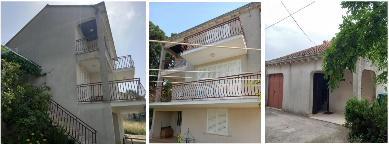
Slika 77., 78. i 79. Bočno pročelje (lijevo), glavno pročelje (sredina) i gornji ulaz (desno) (Fotografirao: Š. Špaleta, 9. lipnja 2024.)
