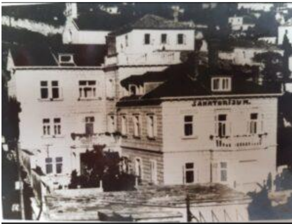
Slika 109. Zgrada starog rodilišta na Pilama (preuzeto: dubrovnikinsider.hr, 1. 6. 2024.)
