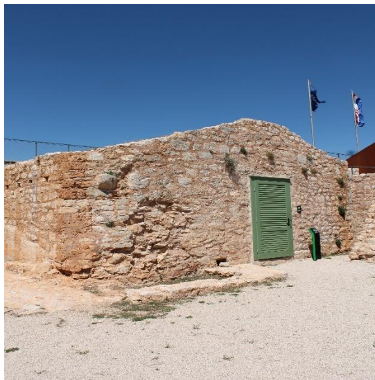
Slika 70. Pogled na glavno pročelje barutane na tvrđavi sv. Ivana, 2024. godine
