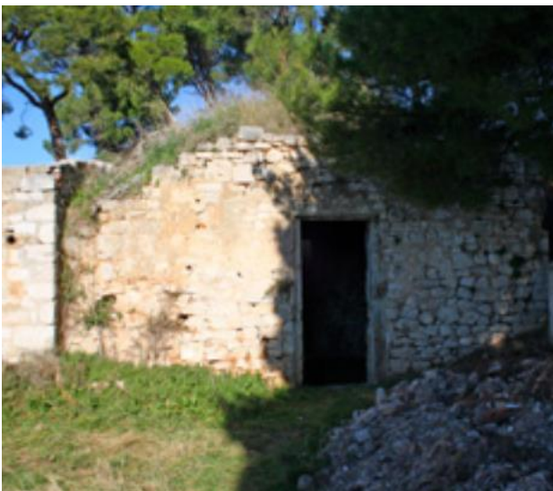
Slika 69. Pogled na glavno pročelje barutane na tvrđavi sv. Ivana, 2016. godine
