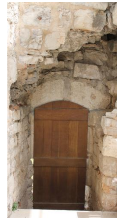
Slika 11. Vrata uz manju poligonalnu kulu smještenu na sjevernoj kortini
