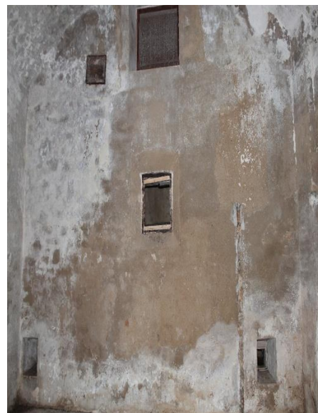
Slika 45. Detalj začelnog zida barutane
