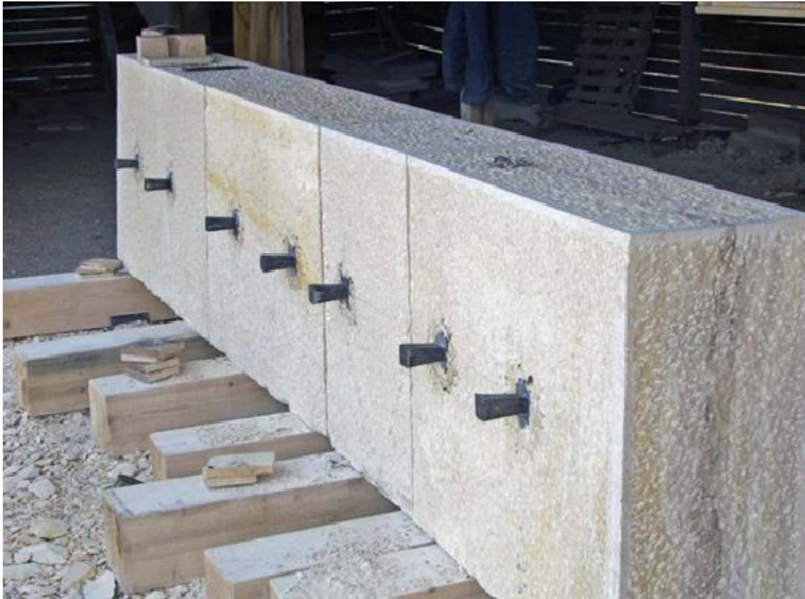
Slika 10. Red isklesanih i pripremljenih kamenih blokova za jedan red luka mosta, ekstrados je gore, ugrađeni klinovi su na naližežućoj strani reda (foto: Ž. Peković). (Preuzeto iz Milošević, Peković, 2009. str.390)
