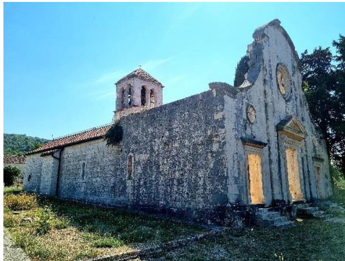
Slika 44. Pogled na bočne zidove
