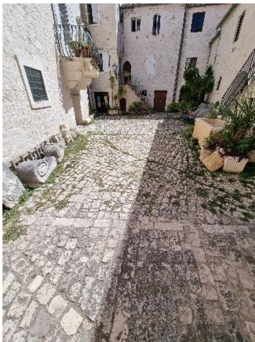
Slika 45. Izvorno popločenje na istočnom dijelu i obnova popločenja na zapadnom dijelu unutarnjeg dvorišta palače Garagnin Fanfogna u Trogiru
