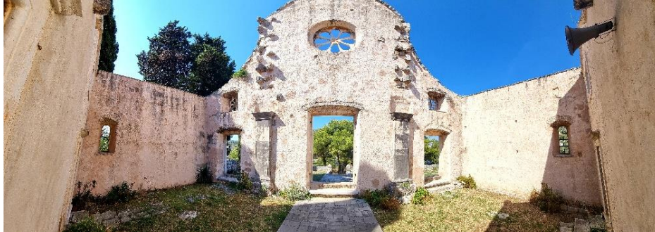
Slika 43. Pogled na unutrašnje zidove
