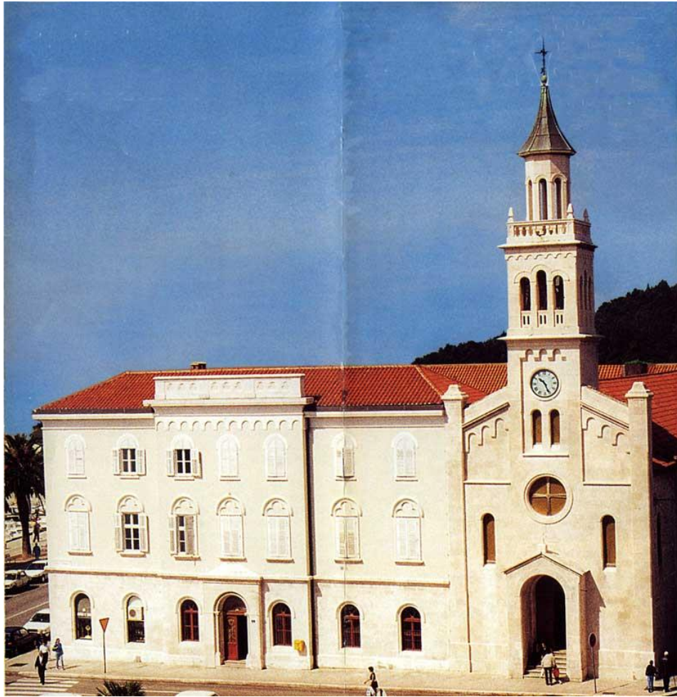
Slika 3: Splitski samostan svetog Frane na Obali
