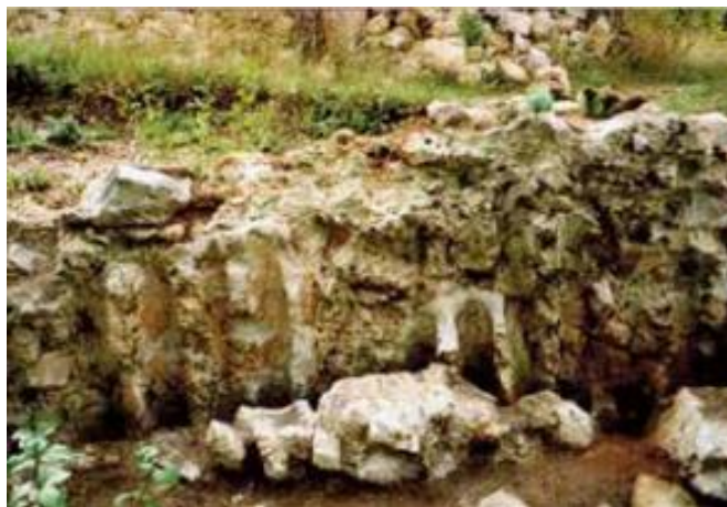
Slika 43. Temelji palisada otkopani 1999. godine
