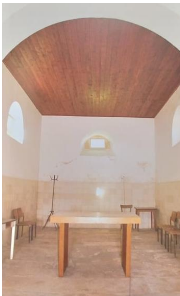
Slika 58. Svetište crkve sv. Roka prije obnove
