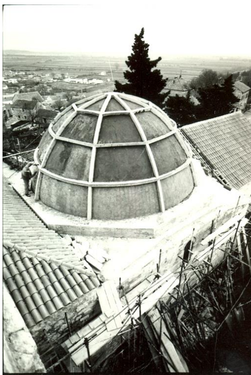
Slika 43. Ferrocementna kupola
