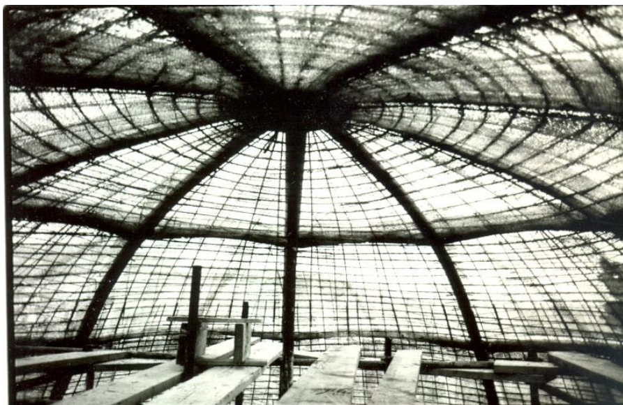
Slika 41. Armatura ferocementene kupole
