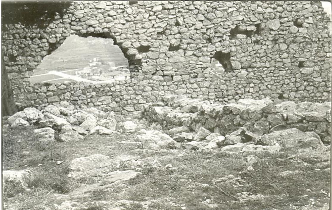
Slika 26. Obodni zid i spojni zid prije rekonstrukcije 1988. godine
