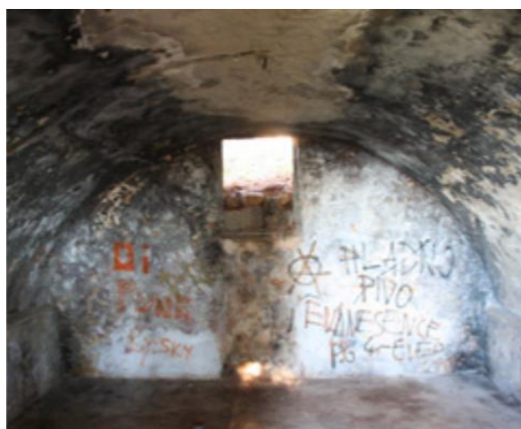
Slika 19. Unutrašnjost barutane na tvrđavi sv.Ivana (preuzeto iz: I. Glavaš, 2017., str. 223., snimio: I. Glavaš)
