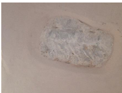
Slika 109 Ulomak s ostatkom ukrasa palmete, pronađen tijekom restauratorskih radova 2020., Gospe od Zvonika (foto: A. Ujević)
