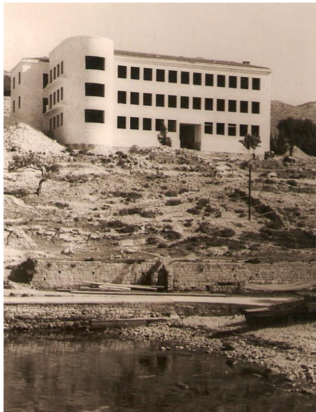
Slika 3. Nova školska zgrada pred sam kraj izgradnje, 1939. godine
