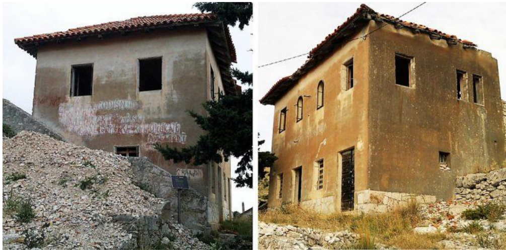
Slika 15. Školska zgrada u Zračima izgrađena 1928. godine
