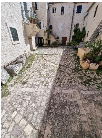
Slika 24. Izvorno popločenje na istočnom dijelu i obnova popločenja na zapadnom dijelu unutarnjeg dvorišta palače Garagnin Fanfogna
