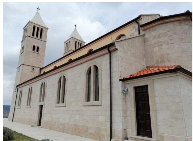
Slika 74. Vanjski izgled južnog pročelja (Foto: Marko Kojundžić)
