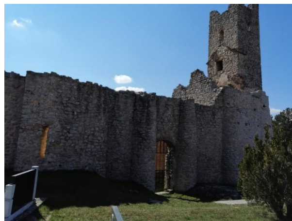
Slika 62. Sjeverno pročelje (Foto: Marko Kojundžić)
