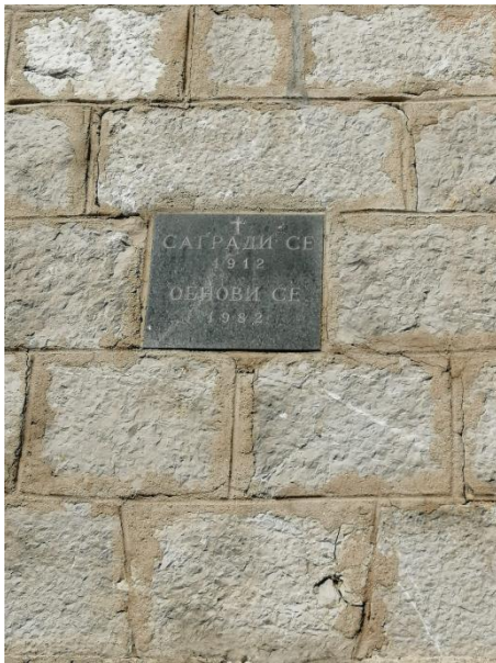
Slika 29. Ploča s podacima od gradnji i obnovi (Foto: Marko Kojundžić)
