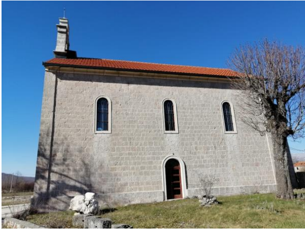
Slika 34. Jugoistočno pročelje (Foto: Marko Kojundžić)
