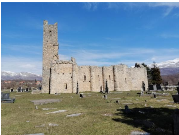
Slika 61. Južno pročelje (Foto: Marko Kojundžić)
