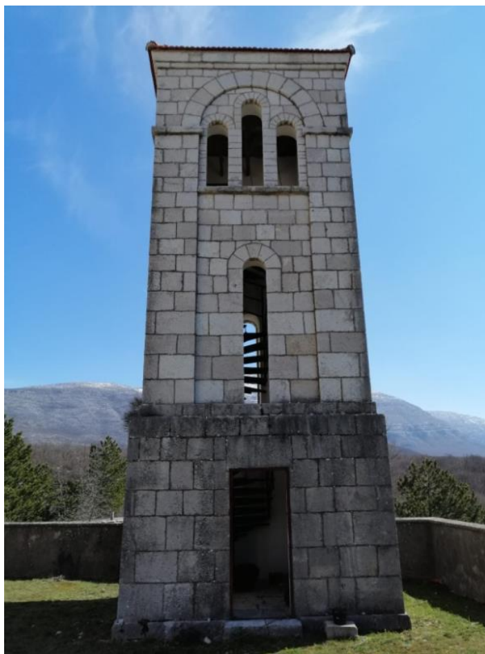
Slika 68. Vanjski izgled zvonika (Foto: Marko Kojundžić)
