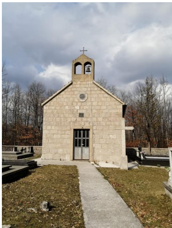
Slika 25. Glavno pročelje (Foto: Marko Kojundžić)
