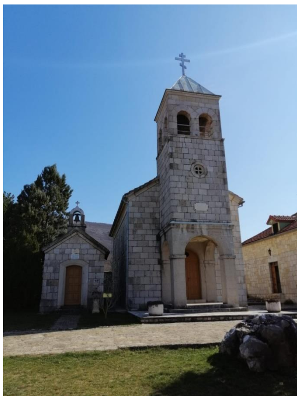
Slika 39. Ulazno pročelje s dograđenom kapelom (Foto: Marko Kojundžić)
