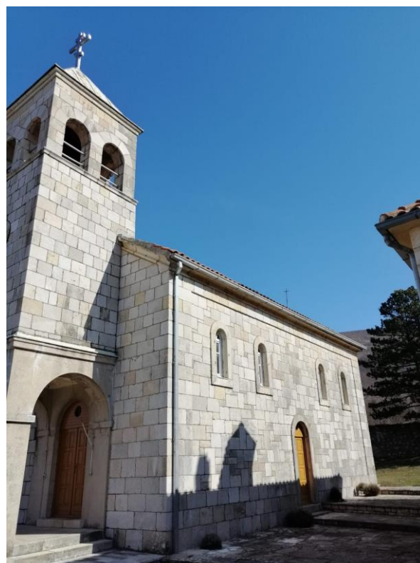
Slika 40. Južno pročelje (Foto: Marko Kojundžić)
