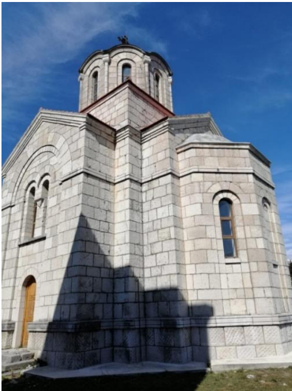
Slika 66. Južno pročelje s apsidom (Foto: Marko Kojundžić)
