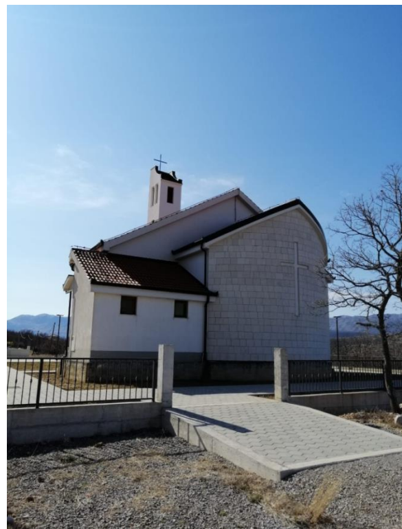
Slika 48. Crkveno začelje orijentirano prema zapadu (Foto: Marko Kojundžić)
