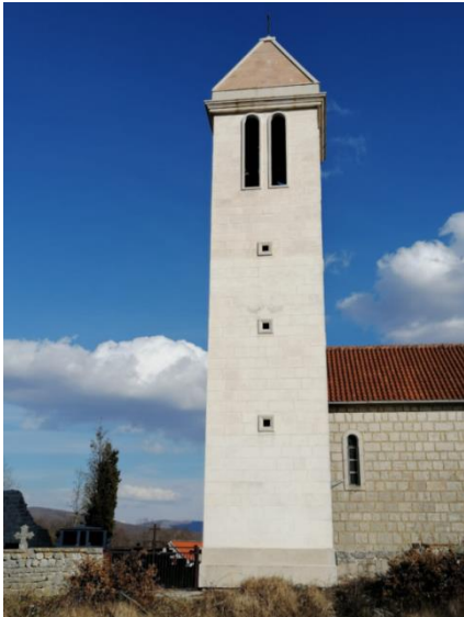
Slika 22. Vanjski izgled zvonika (Foto: Marko Kojundžić)
