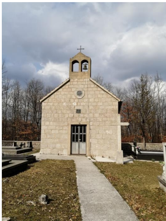
Slika 25. Glavno pročelje (Foto: Marko Kojundžić)
