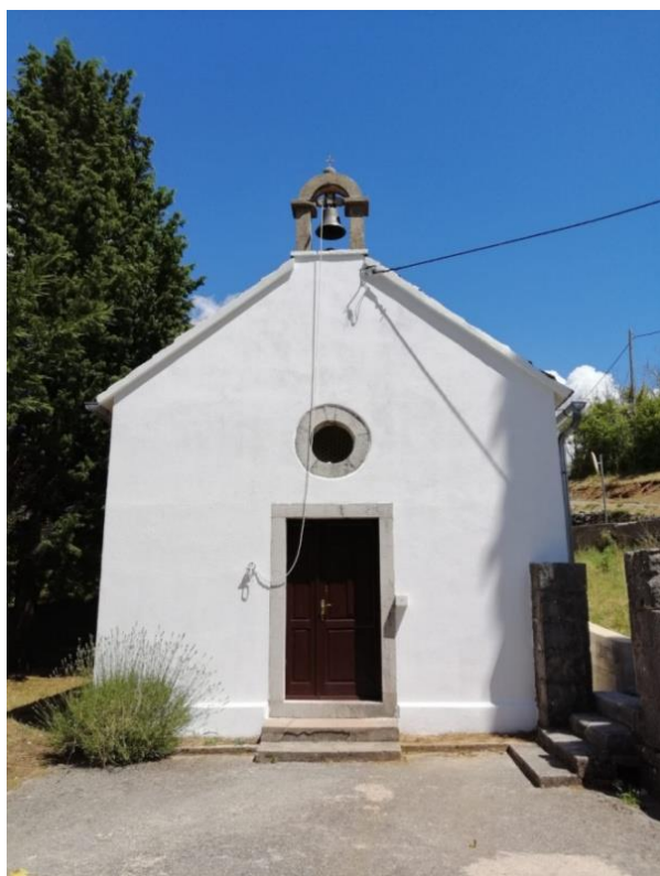
Slika 76. Glavno pročelje (Foto: Marko Kojundžić)
