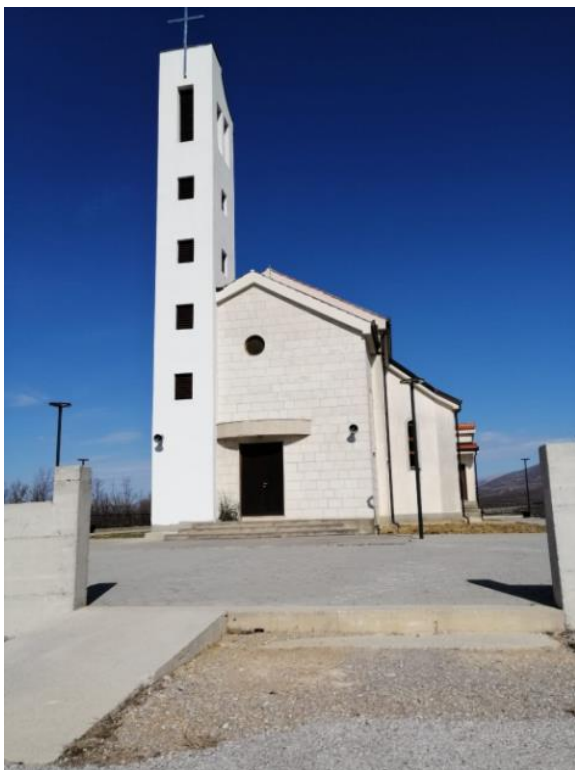
Slika 47. Glavno pročelje orijentirano prema istoku (Foto: Marko Kojundžić)
