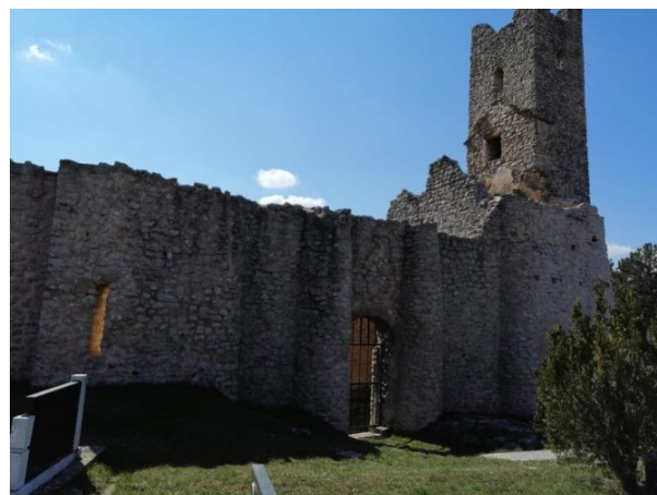
Slika 62. Sjeverno pročelje (Foto: Marko Kojundžić)
