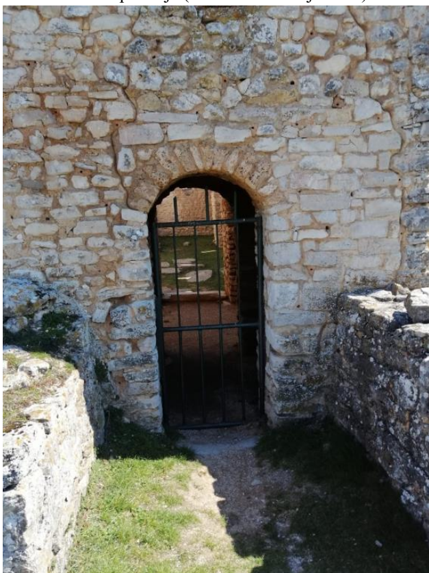
Slika 63. Ulaz na zapadnom pročelju (Foto: Marko Kojundžić)
