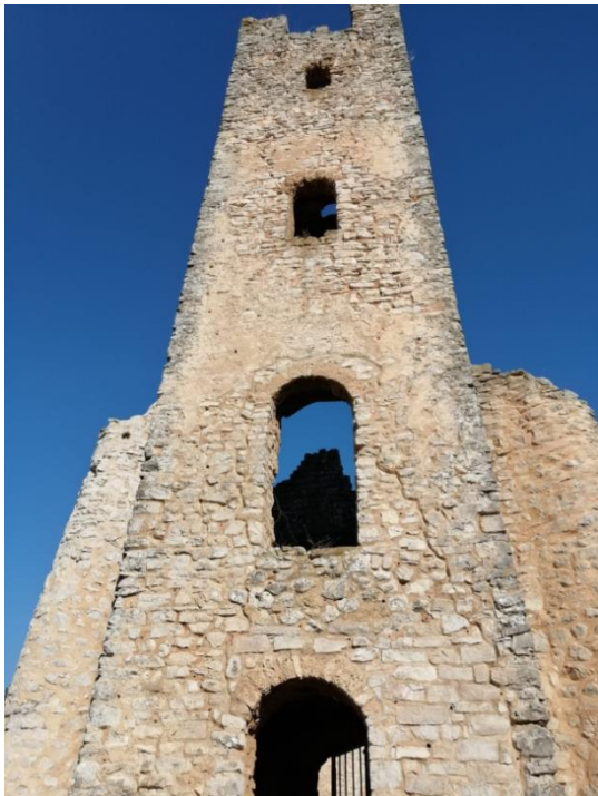
Slika 57. Vanjski izgled zvonika (Foto: Marko Kojundžić)
