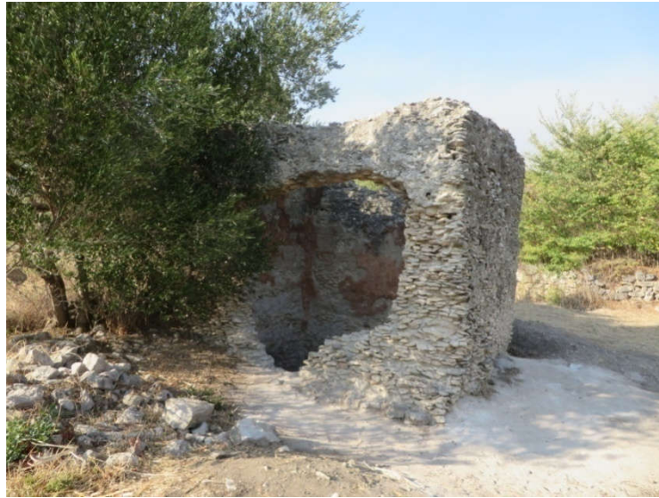
Slika 25. Opus caementicium -Cisterna na Murteru (Colentum)
