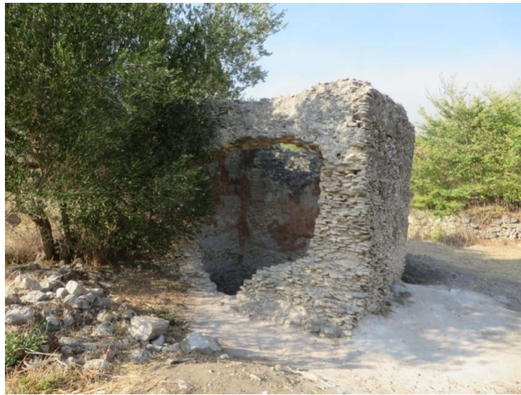
Slika 25. Opus caementicium -Cisterna na Murteru (Colentum)
