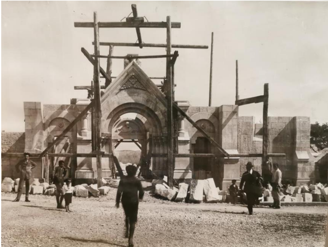
Slika 30: Gradnja crkve u Selcima (izvor: selačka crkva)
