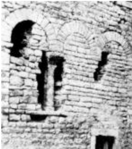
Slika 62. Otvaranje zazidanog trodijelnog prozora (Izvor: D. Domančić, 1994.)
