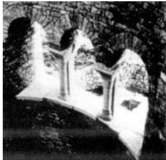
Slika 63. Trodijelni prozor s izvornim stupićima i kapitelima s impostima nakon odzidavanja (Izvor: D. Domančić, 1994.)
