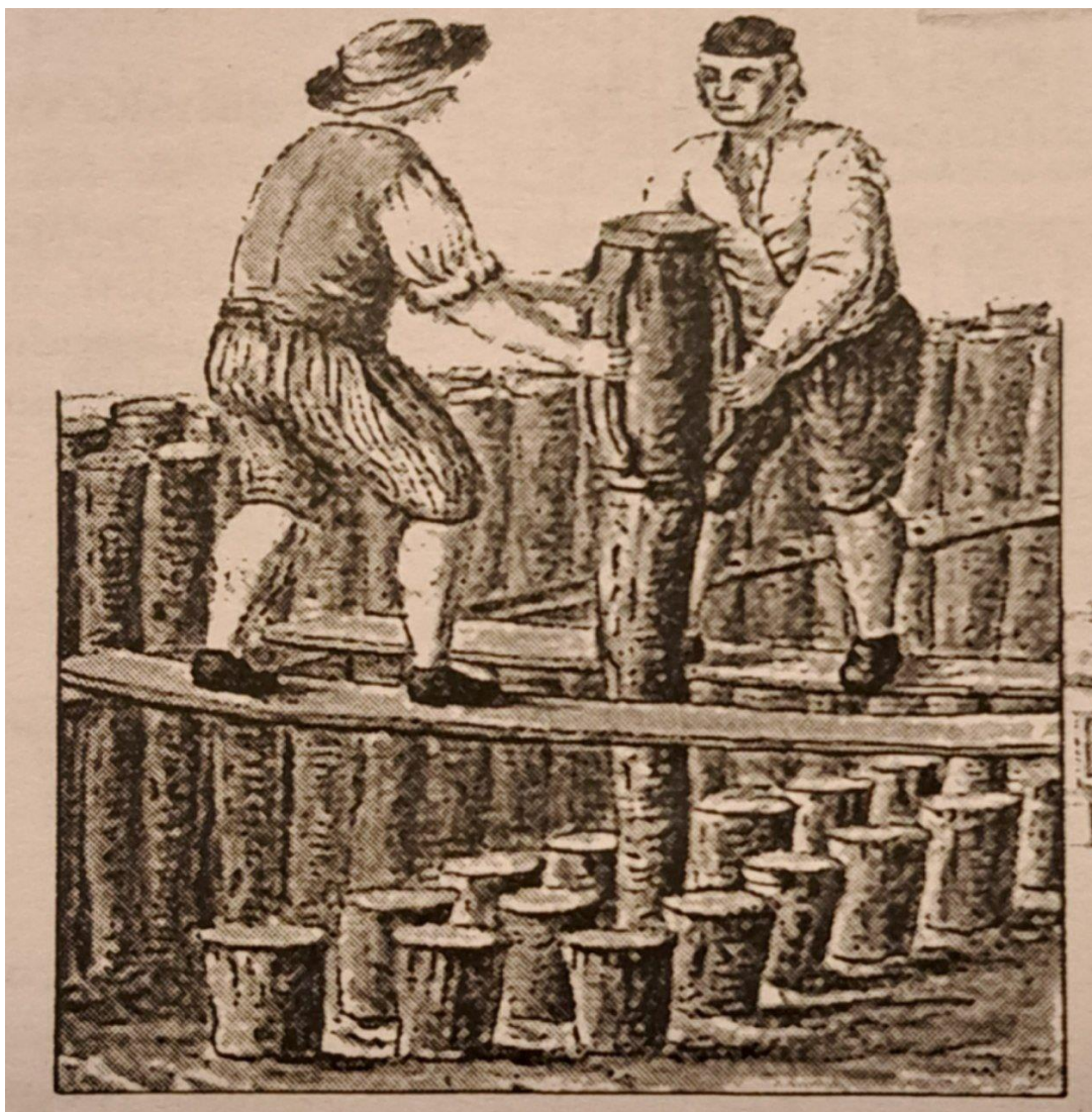
Slika 8: Rekonstrukcija tehnike gradnje u samim počecima Venecije
