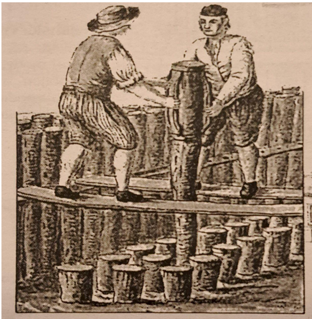
Slika 8: Rekonstrukcija tehnike gradnje u samim počecima Venecije
