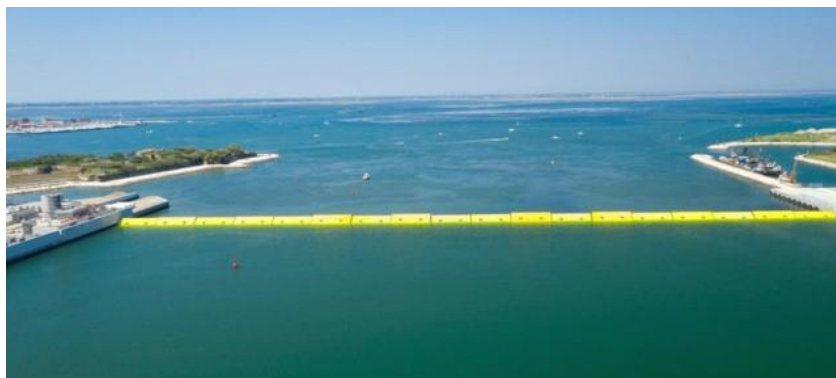
Slika 48: Mobilne barijere sustava MOSE
