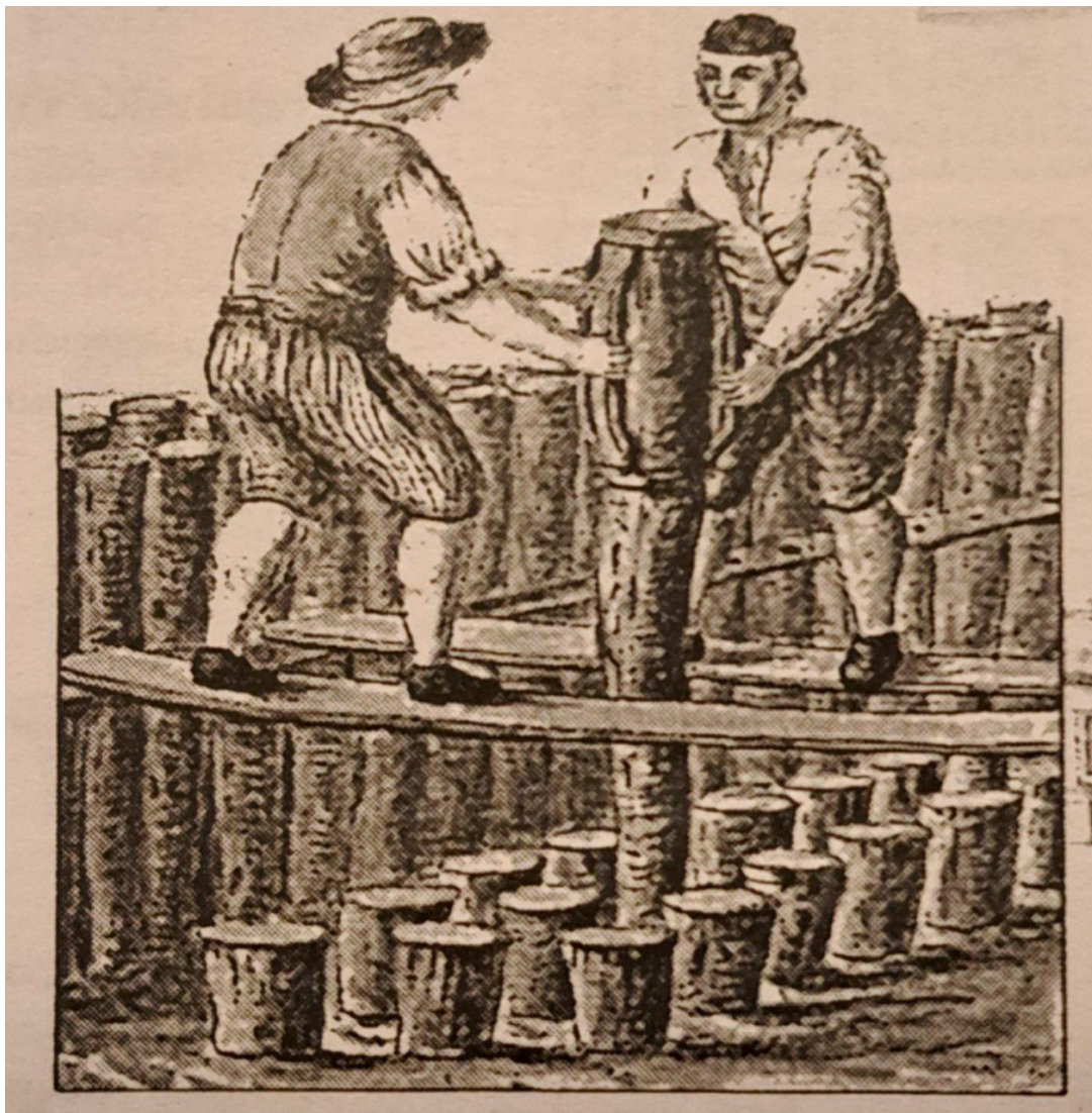
Slika 8: Rekonstrukcija tehnike gradnje u samim počecima Venecije
