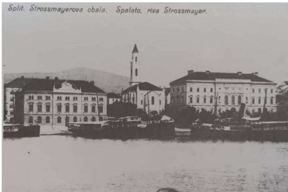
Slika 49. Zgrada režije duhana u splitskoj luci (lijevo) (preuzeto: Piplović S., Kamilo Tončić , Split, 1991., 73.)
