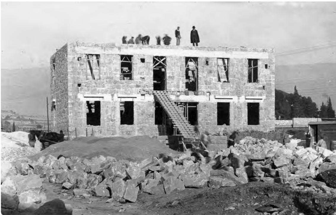
Slika 35. Kuća u izgradnji (privatno vlasništvo)
