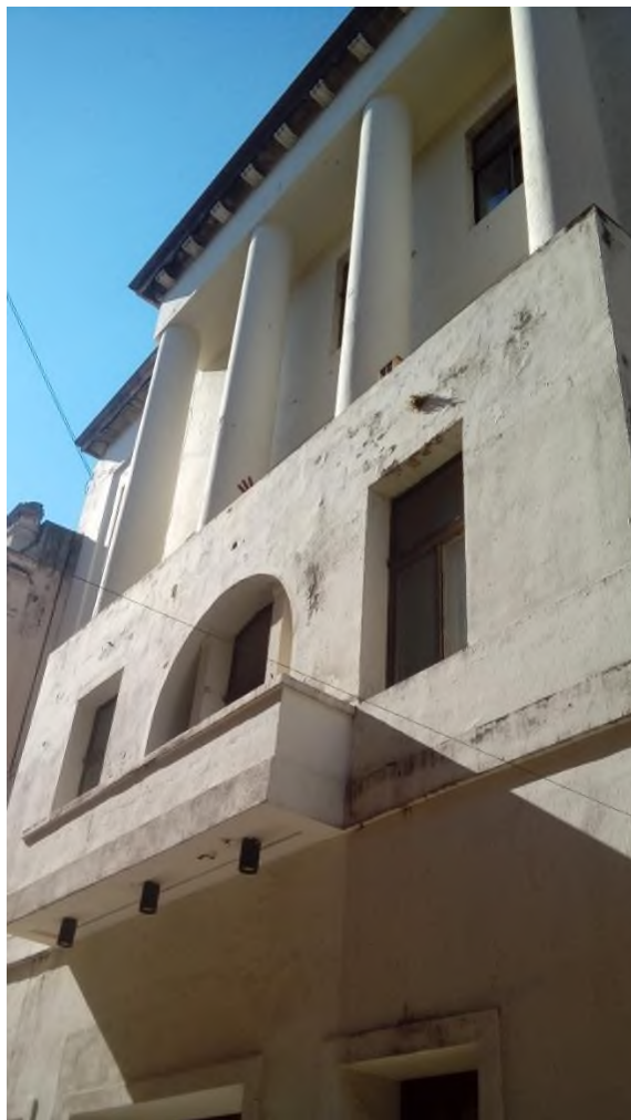
slika 28. Zatečeno stanje zgrade Hrvatskog doma prije restauracije, 2017. (privatno vlasništvo)
