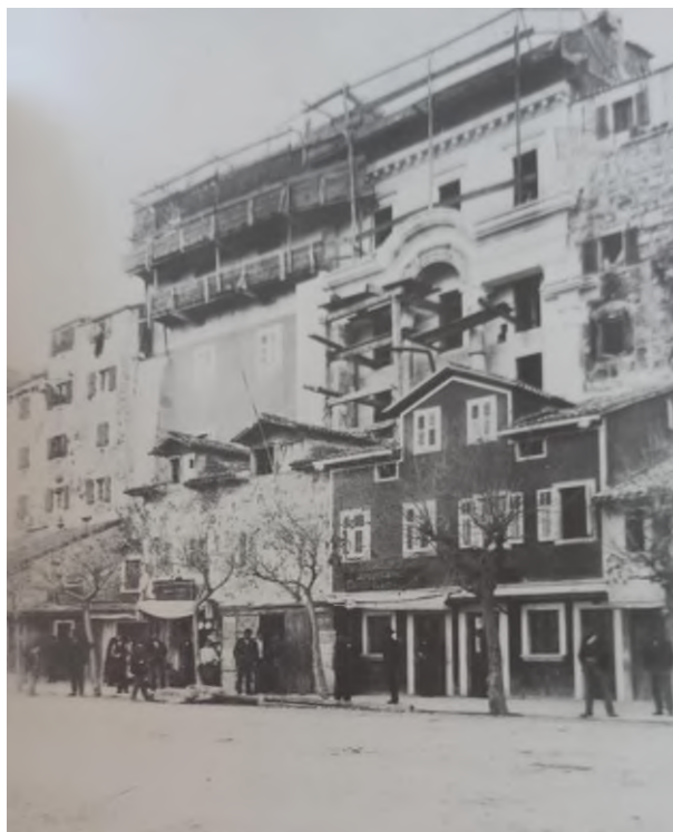
Slika 47. Kuća I. Save, tijekom nadogradnje sa skelom na mansardi (preuzeto: Piplović S., Kamilo Tončić, Split, 1991., 61.)
