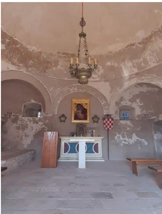
Slika 34: Crkva svetog Vida; unutrašnjost.
