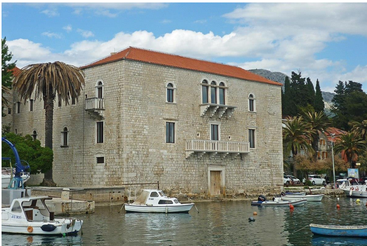
Slika 8 Kaštel Vitturi – sadašnji izgled
