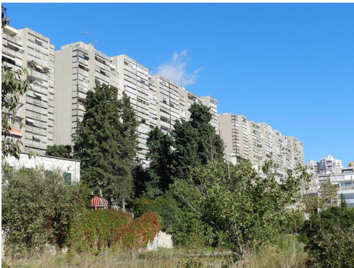
Slika 16. Pogled na zgrade u Papandopulovoj ulici
