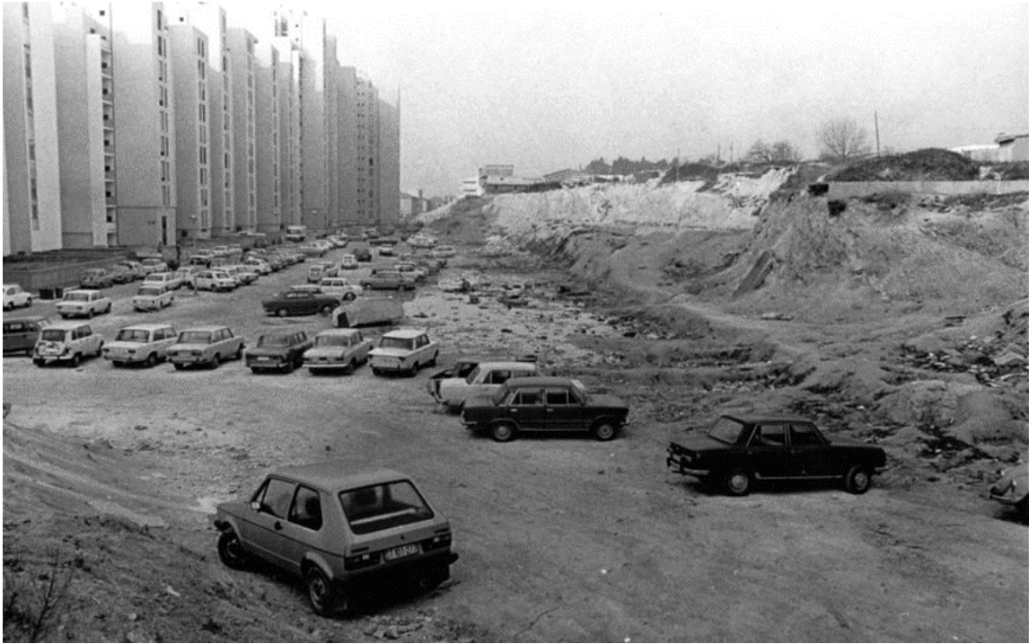
Slika 21. Parking na Sućidru, 1983.
