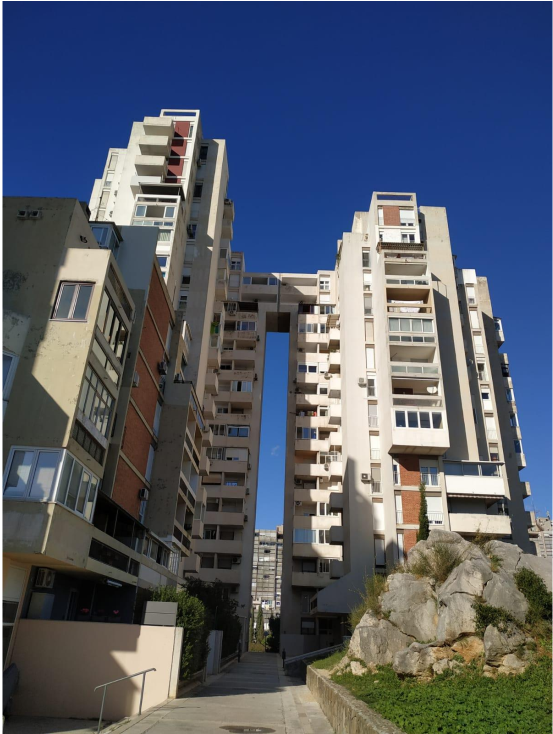
Slika 13. Pogled na zgradu u ulici braće Borozan
